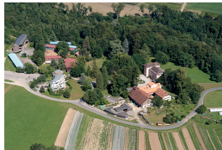
Vue aérienne, l'école Steiner: à gauche; la ferme et le domaine: à droite
