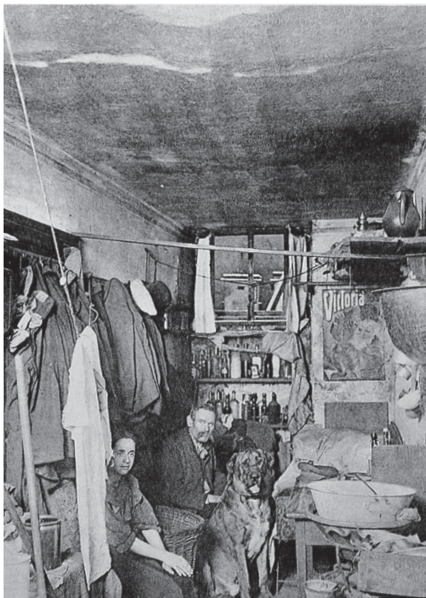
Logement ouvrier insalubre, Berlin, 1905
