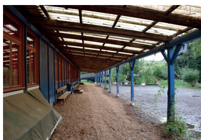
pavillon coursive intérieure
