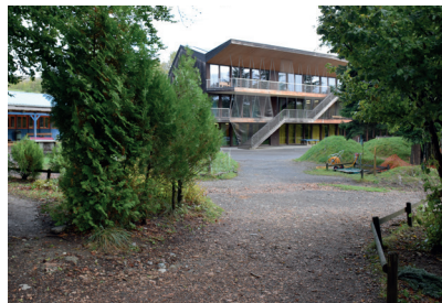
nouveau bâtiment, coursives extérieures
