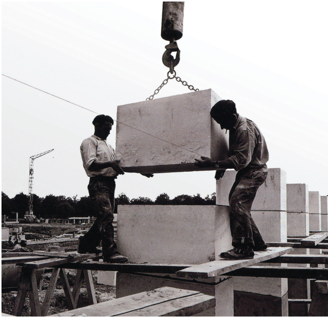
Pose d'un bloc de pierre taillée pour les ordonnances de l'ensemble de Meudon-la-Forêt, « Le métier d'architecte... autrement », article de Michel Raynaud, Jean-Lucien Bonillo, Fernand Pouillon : architecte méditerranéen , op. cit., p.156.
