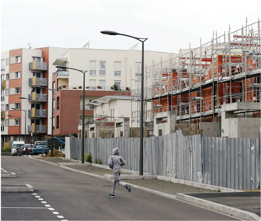
Logements sociaux en construction à Clichy-sous-bois, photographie de Alain Jocard / AFP, « Dans quelle situation économique se trouvent nos banlieues ? », Le Figaro , 27 octobre 2015.
