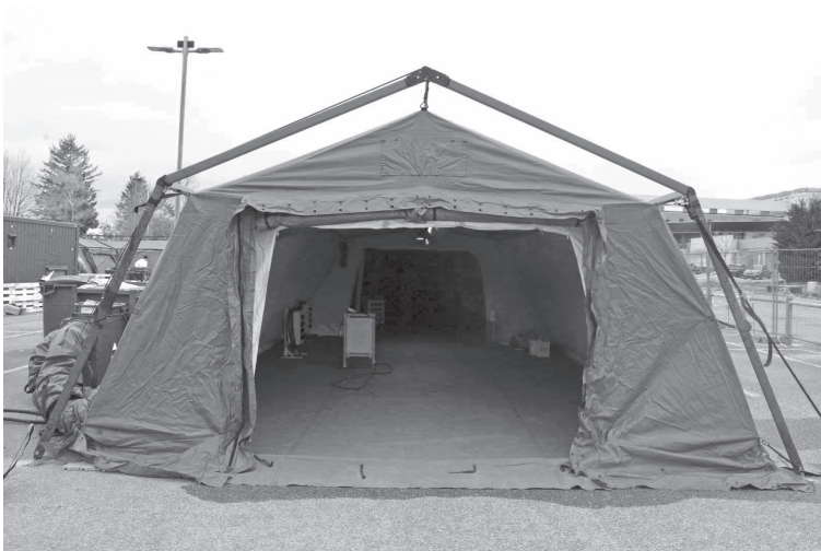
Une fois le montage terminé, un système de ventilation à air chaud est raccordé à chaque tente (à gauche). © Darek Szuster / L'Alsace
