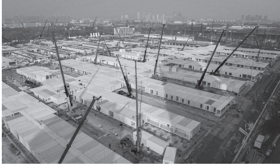
Chantier de l'hôpital Leishenshan à Wuhan © ZHENGYANG via Xinhua
