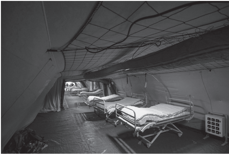
Vue intérieure d'une aile de traitement. Ventilation et éclairage sont suspendus en haut de chaque cadre. Des branchements électriques sont tirés pour chaque lit. © Sébastien Bozon / AFP
