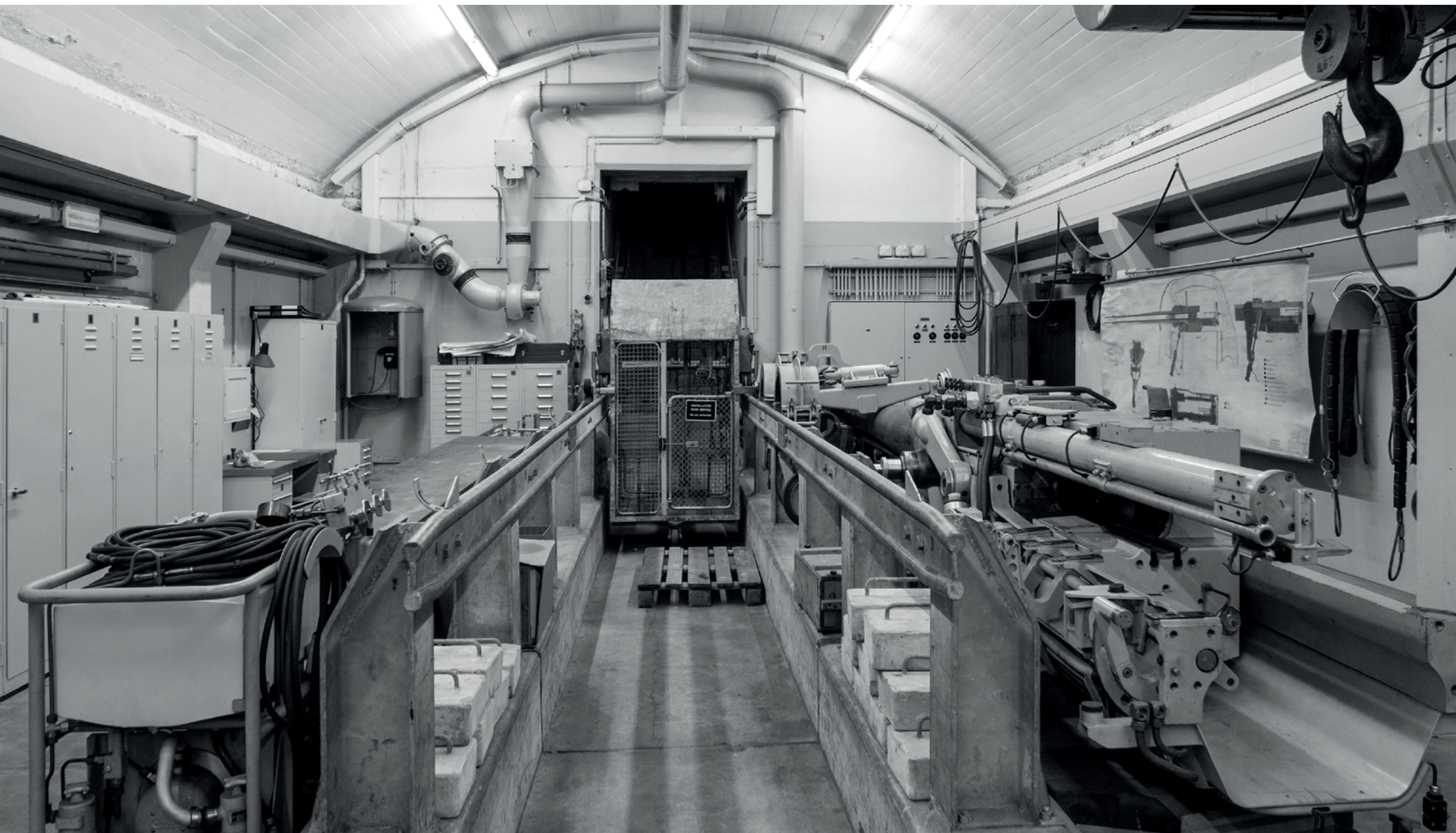
Fort de Dailly au-dessus de Saint-Maurice (construit dès 1892) Atelier de réparation des douilles d'obus des canons tourelles automatiques
