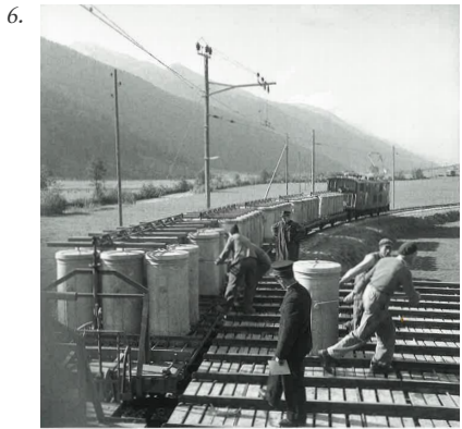
HAUT Wagons avec bennes métalliques de ciment (près de la cimenterie de Roche et en route vers le Valais pour les chantiers des barrages de Mauvoisin et de la Grande-Dixence).
