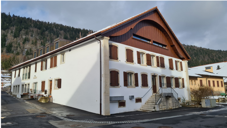
(Fig.15) Cernier, Ferme jurassienne réhabilitée.
