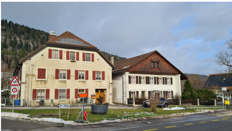
(Fig.17) Chézard Saint-Martin, Fermes à pignon frontal.
