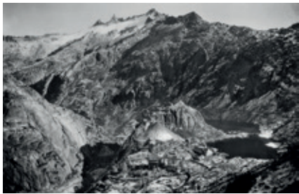
fig. 11. [s.n.]. 1928. Uebersicht der Bauinstallationen, Spitalamm, Grimselnollen, altes und neues Hospiz, Grimselseen, umgelegte Grimselstrasse, Gerstenhörner. Archiv KWO.
