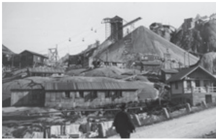
fig. 12. Wehrli, Leo. 1929. Grimselwerk, Installationen und Betonkies-“Sparkasse”. Photographie : plaque de verre positive. ETH Library Zurich, Image Archive
