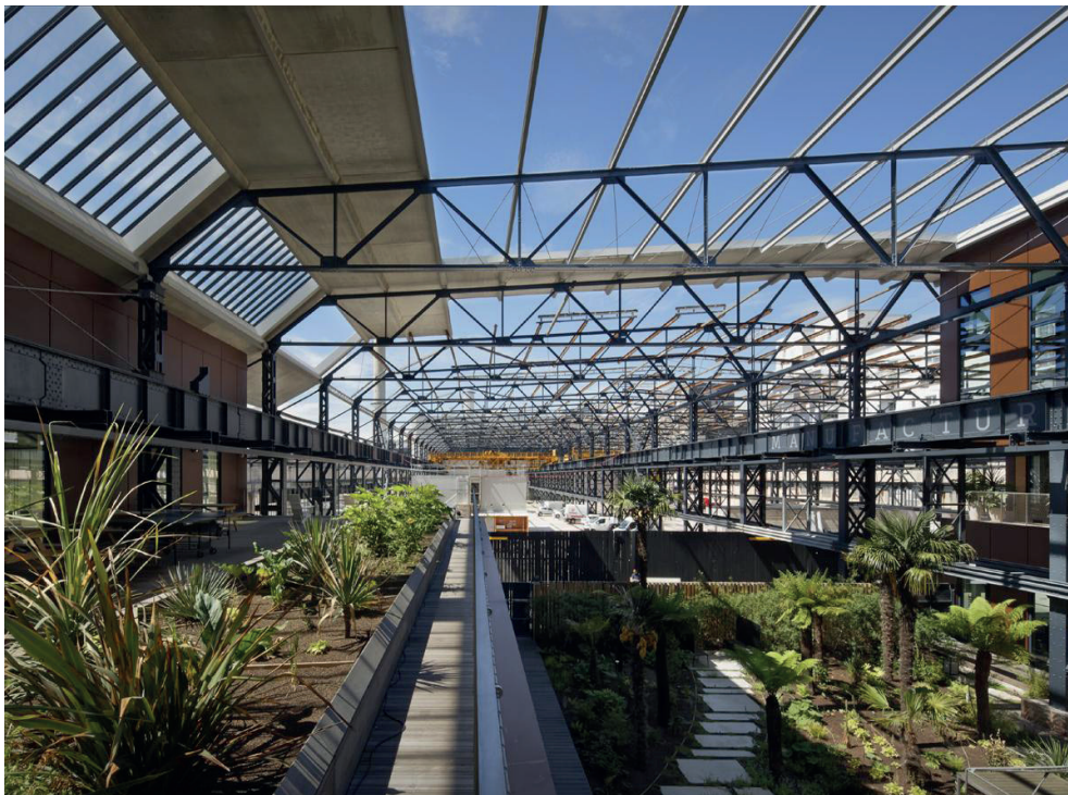
Fig.52 Halle Alstom (Saguez), Saint-Ouen (FR). Vue sur la structure et la partie Ouest de la demi-halle. Reichen & Robert, 2016 (photo : Camille Gharbi, Halle Saguez , 2022)
