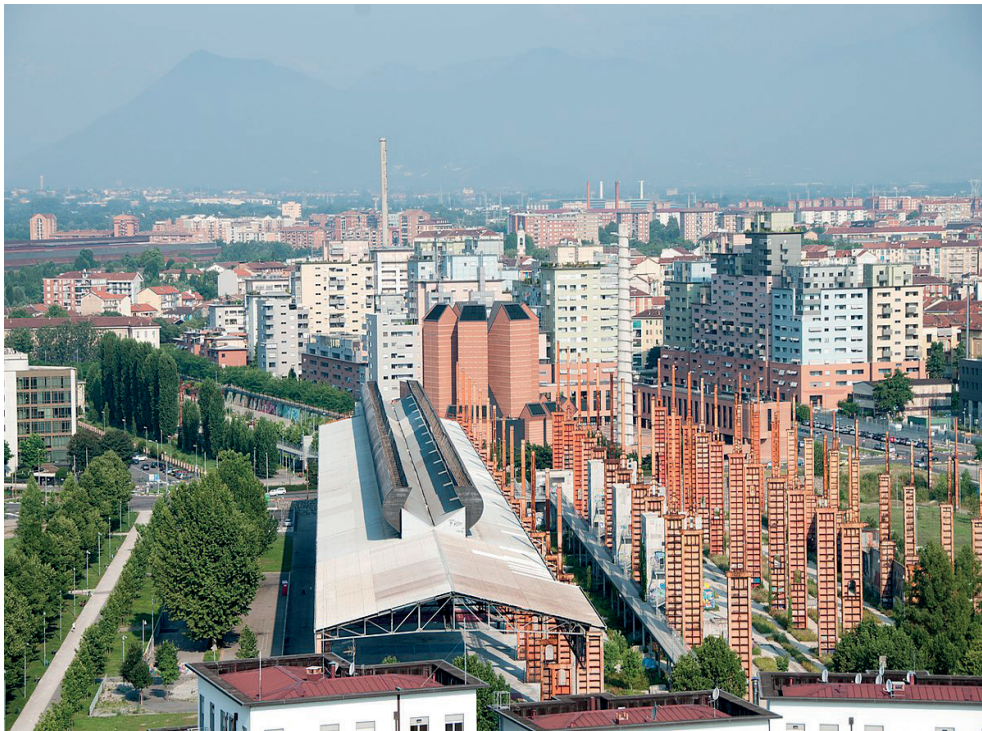
Fig. 3 Parco Dora, Torino (IT). Transformation d'une ancienne usine métallurgique dans un parc urbain. LATZ +PARTNER, 2012 (photo : Uccio, Uccio 2, D'Agostino, 2015)
