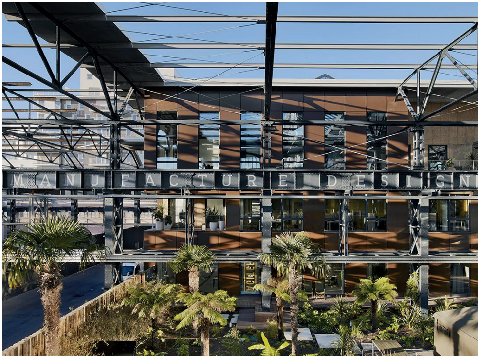
Fig.51 Halle Alstom (Saguez), Saint-Ouen (FR). Volumes sous la halle. Reichen & Robert, 2016 (photo : Camille Gharbi, Halle Saguez , 2022)
