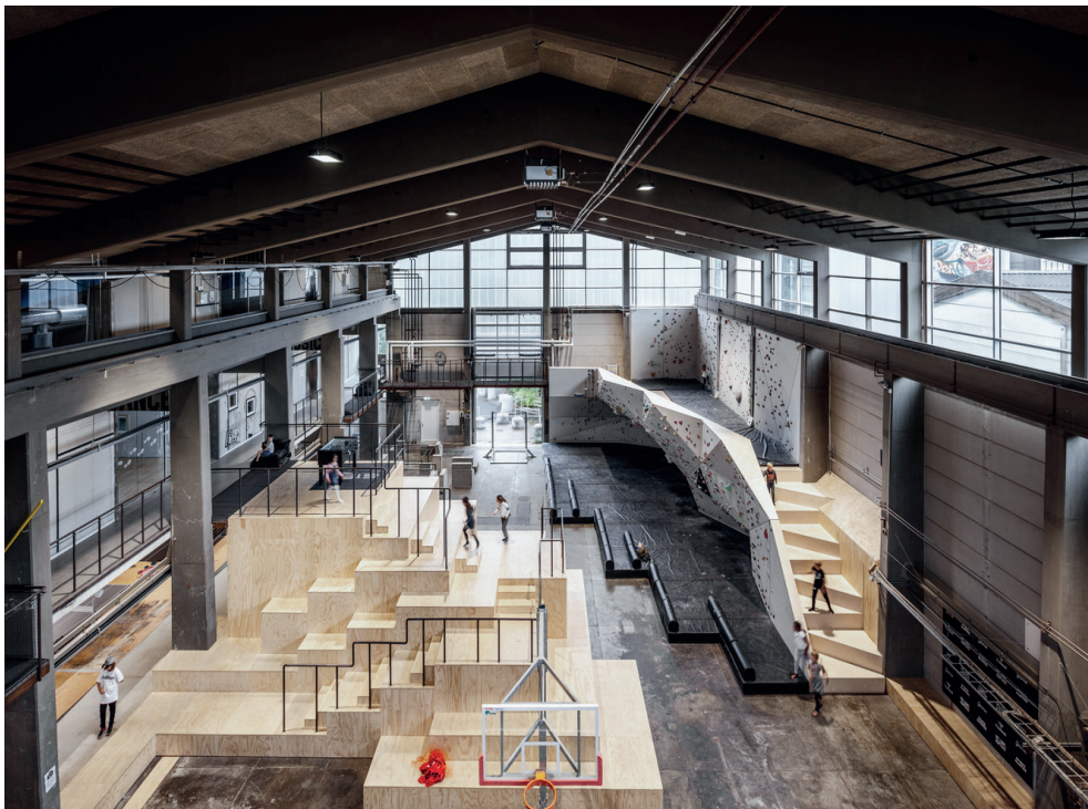
Fig. 46 Game STREETMEKKA, Aalborg (DK). Transformation d'une ancienne halle d'usine en espace de culture urbaine. JAJA architectes, 2018 (photo : Rasmus Hjortshøj, GAME_Streetmekka_Aalborg , 2019)
