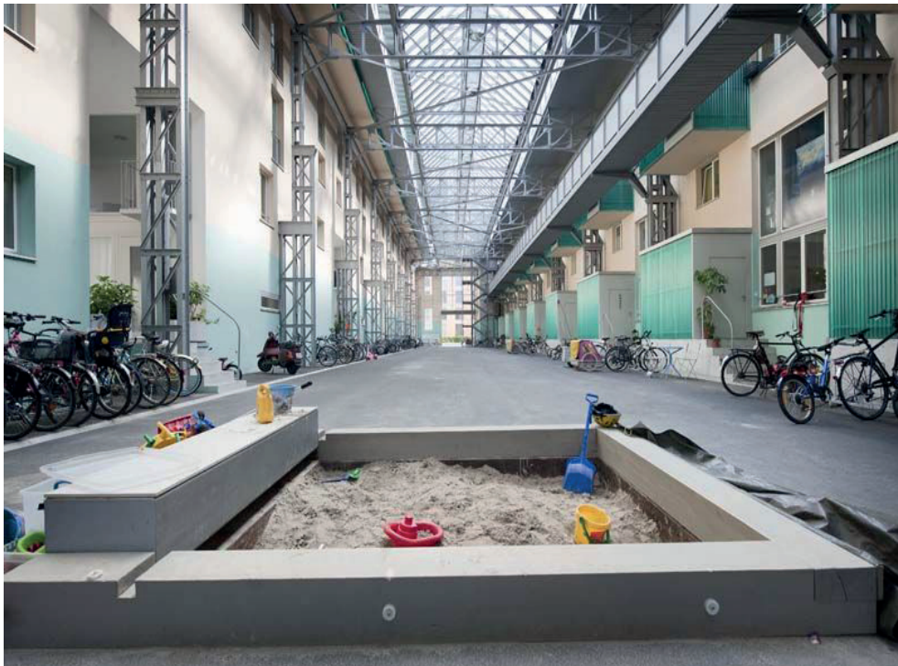
Fig.9 Lokomotive, Winterthur (CH). Transformation d'une ancienne halle métallurgique dans un atrium pour les logements. Knapkiewicz & Fickert, 2006 (photo : Sara, Lokomotive Winterthur)
