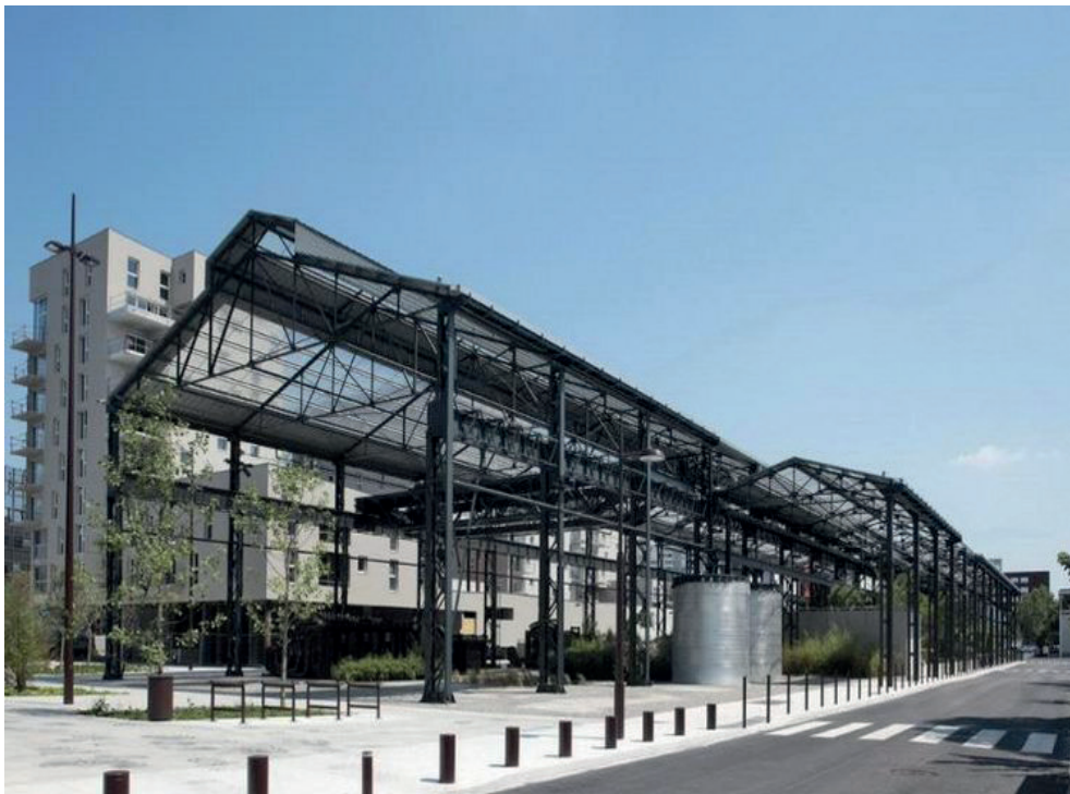
Fig.16 Jardin des Fonderies, île de Nantes (FR). Transformation d'une ancienne halle métallurgique dans un jardin. ADH, 2009 (photo : Hervé ABBA-DIE, Jardin des Fonderies )
