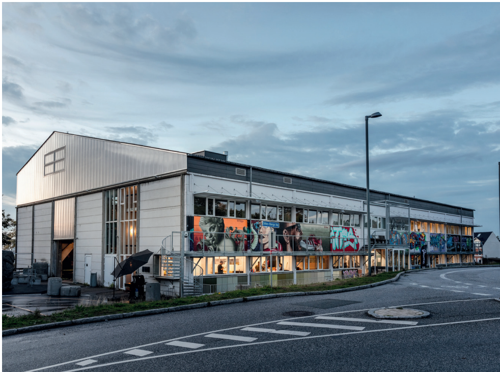
Fig. 45 Game STREETMEKKA, Aalborg (DK). Transformation d'une ancienne halle d'usine en espace de culture urbaine. JAJA architectes, 2018 (photo : Rasmus Hjortshøj, GAME_Streetmekka_Aalborg , 2019)
