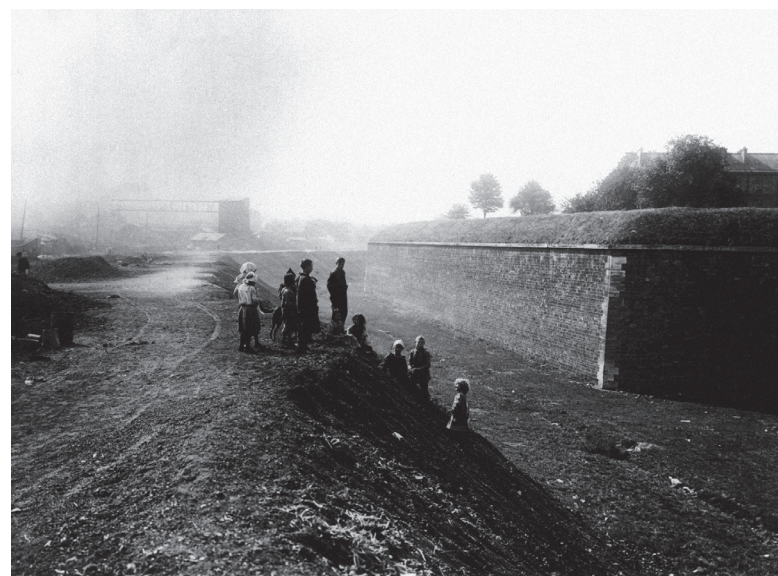
↖ Bastion des fortifications de Thiers
