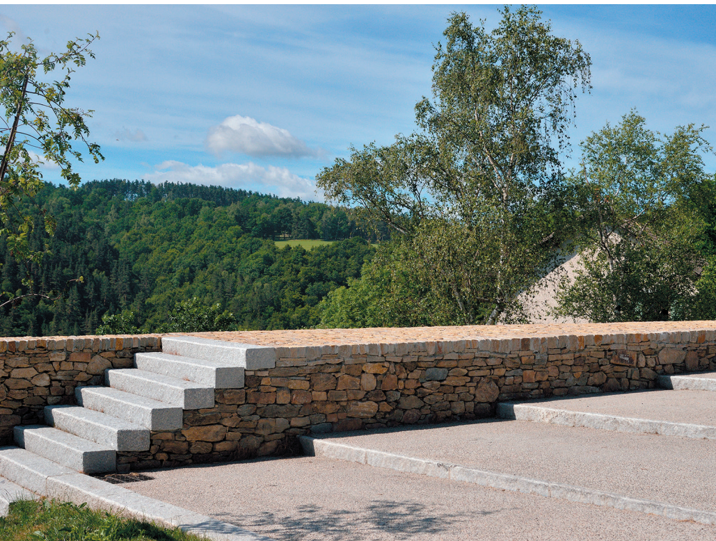
Escalier d'accès au petit belvédère
