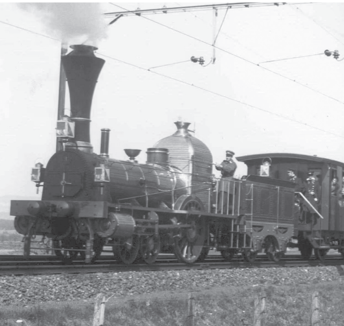
Fig. 1 – Réplique du Spanisch-Brötli-Bahn, premier train de Suisse
