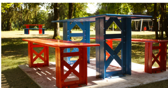
Réutilisation d'ossature en mobilier - Parc des cèdres, Beaucourt
