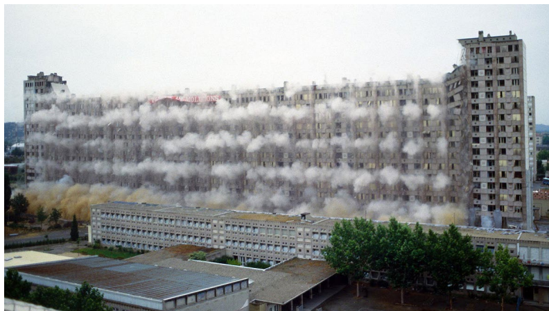
Démolition par explosifs
