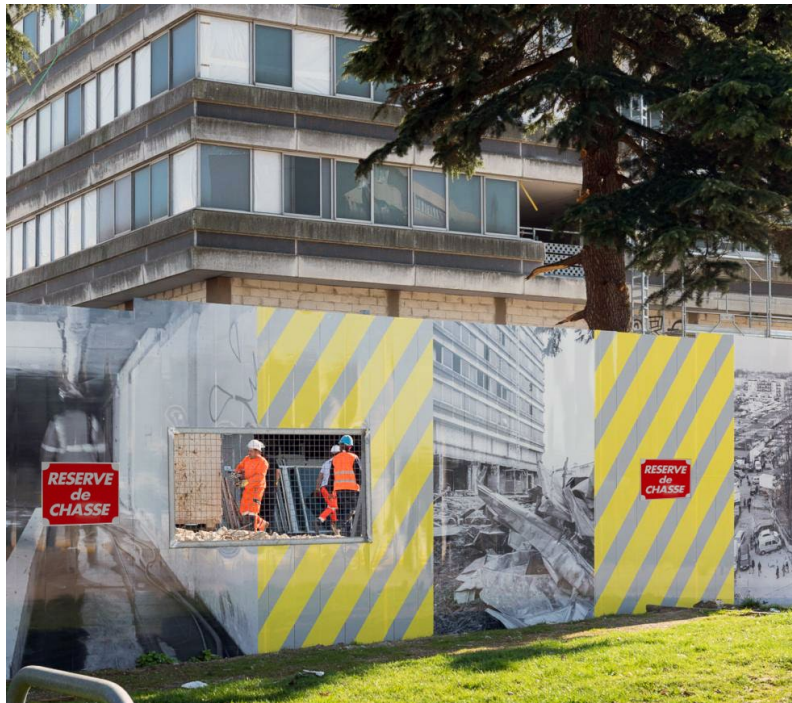
Photomontage réalisée à partir d'une photo de la déconstruction de la tour Utrillo en 2017, à Paris
