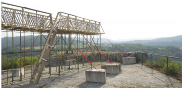
Réemploi de charpente en ouvrage temporaire - Lotteville Skywalk, Raumlabor Berlin
