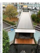
Aussenkamin / cheminée extérieure Canton: ZH Démontage: semaine/année 45/2019
