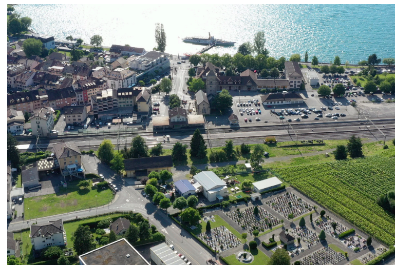
|24| Situation actuelle (juillet 2020) du secteur de la Gare.
