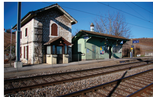
La maison de garde-barrière et le bâtiment des voyageurs
