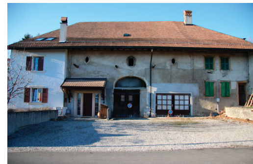
Maison paysanne, rue de l'Eglise
