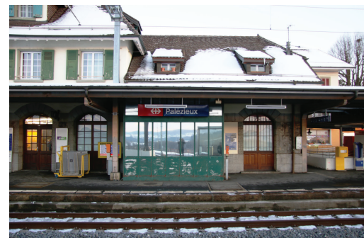
Bâtiment des voyageurs
