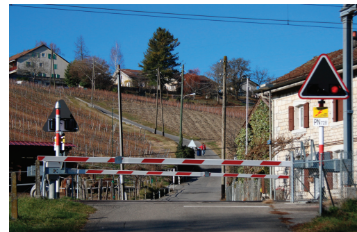
Passage à niveau
