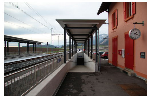
Nouveau passage sous-voie, construit en 2016
