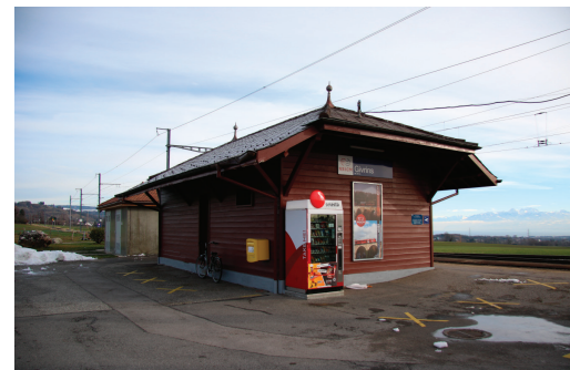
Bâtiment des voyageurs
