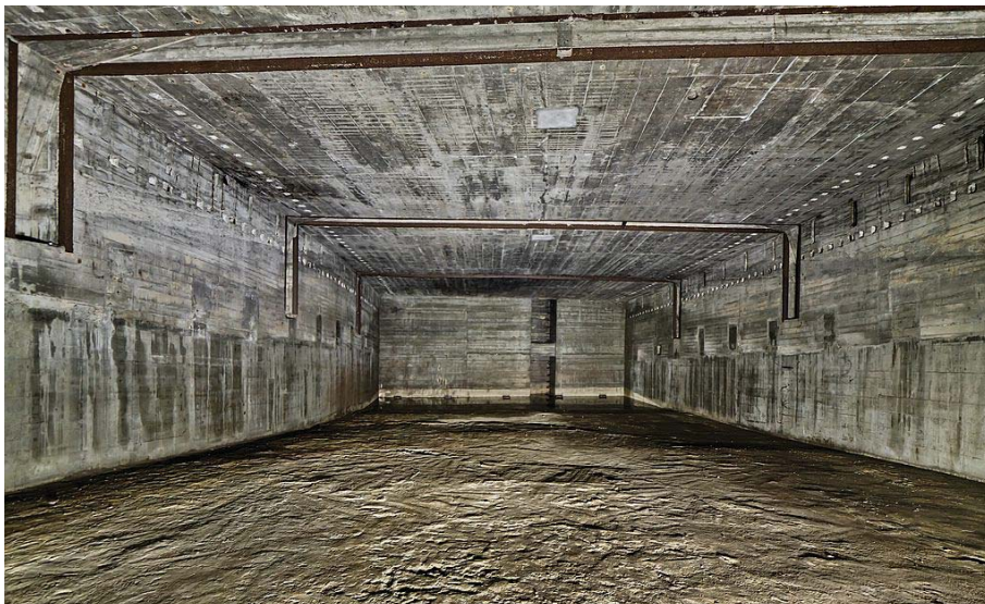
Fig. 41 Tunnel Est avec un des accès possible.
