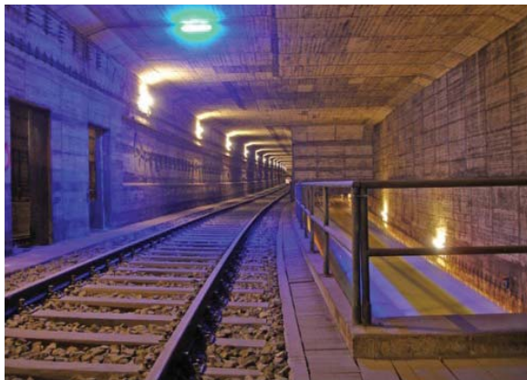
Fig. 40 Rampe de liaison non-utilisée.
