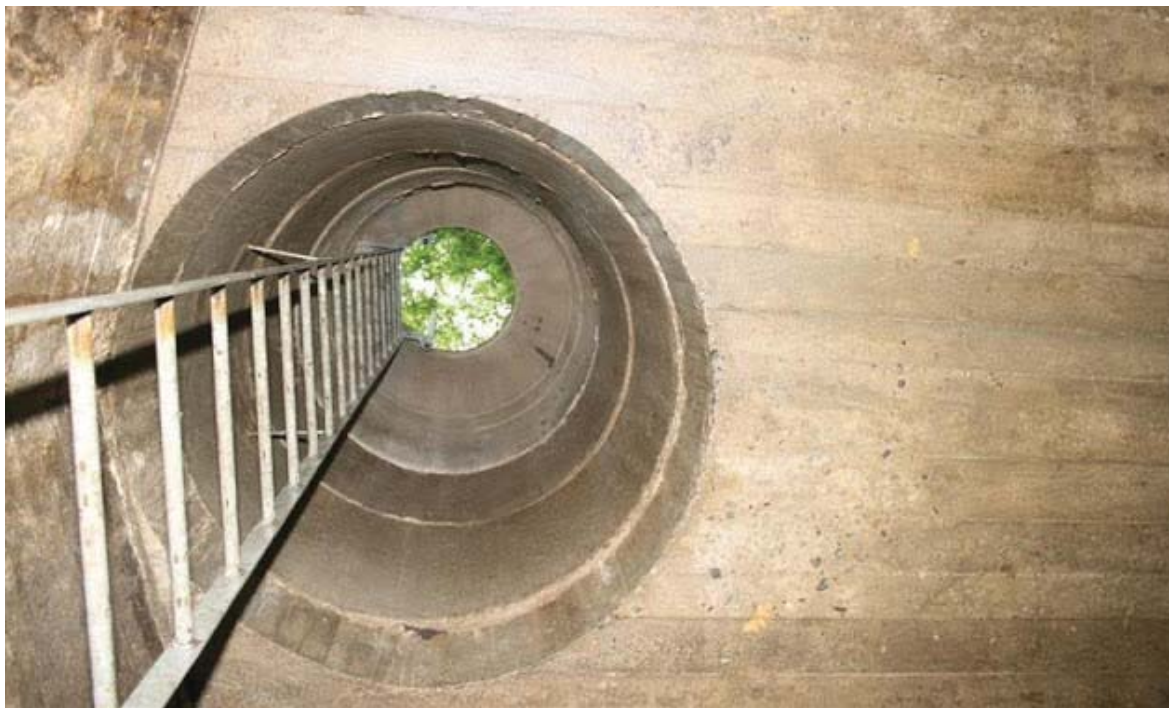
Fig. 47 Puits d'accès à un tunnel.
