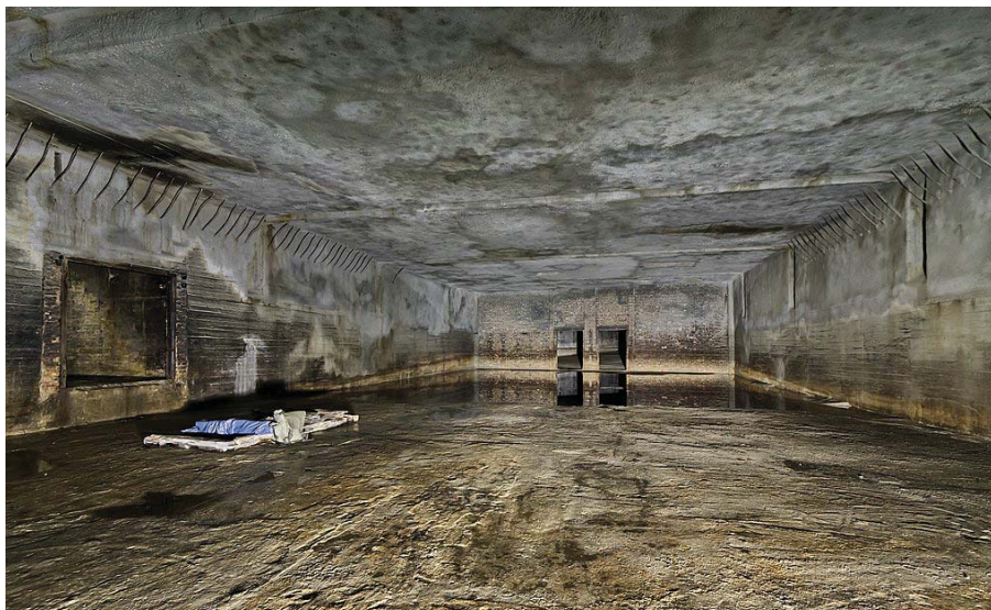
Fig. 44 Tunnel Ouest, autre côté du mur en brique.
