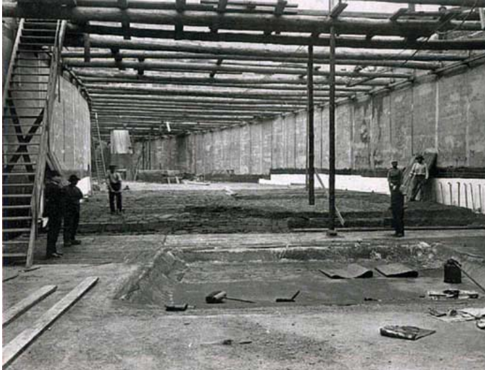
Fig. 23 Construction du tunnel sur la place Viktoria-Louise.
