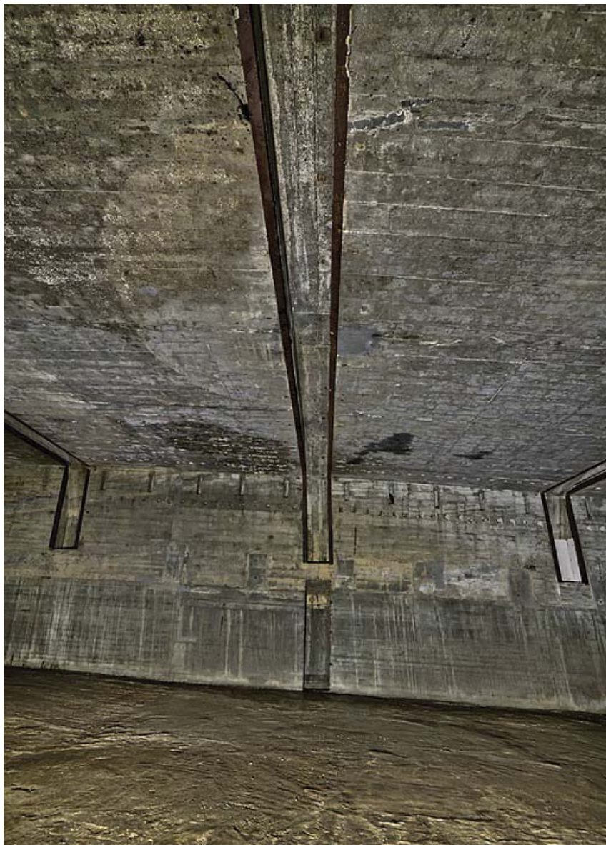
Fig. 50 Saignée pour abriter le système d'éclairage.
