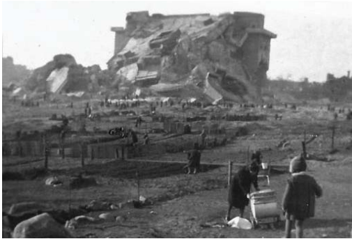
Fig. 69 Photos de la tour G partiellement détruite au Sud.
