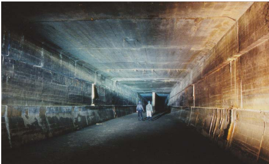
Fig. 55 Tunnel du U-Bahn.
