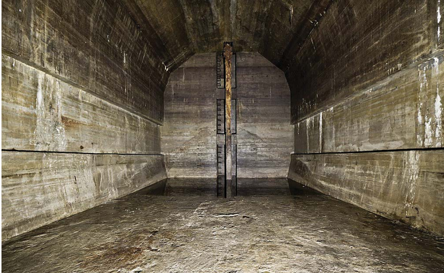
Fig. 57 Fin du tunnel du U-Bahn, avec échelle d'accès..
