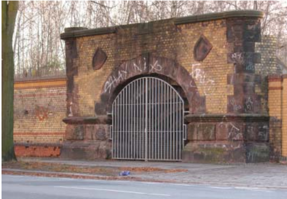
Fig. 5 Entrée Est du tunnel depuis la Gartenstrasse.
