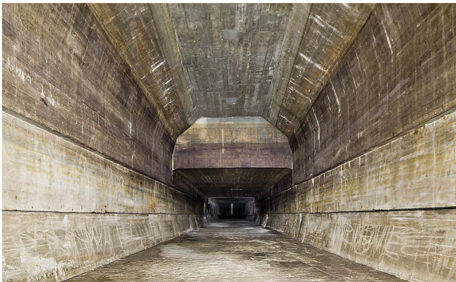
Fig. 56 Tunnel du U-bahn, à l'intersection prévue avec l'«Achsenkreuz».
