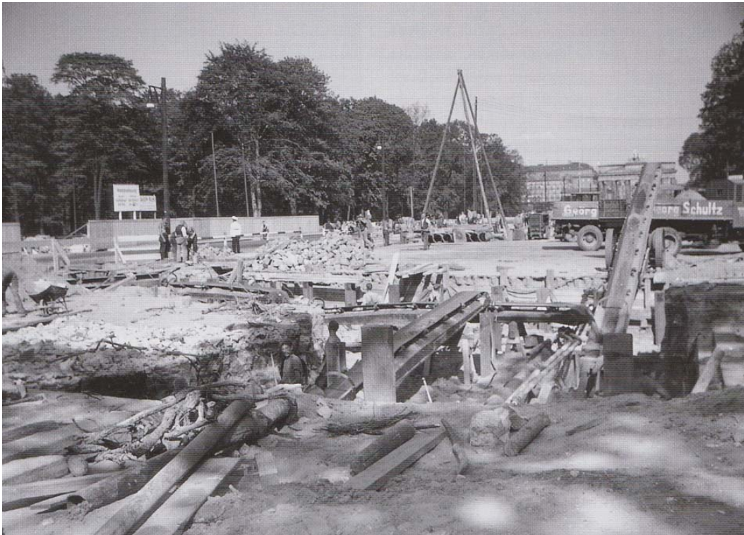
Fig. 61 Construction des Tunnels de l'«Achsenkreuz» sous la rue du 17 juin. Ou l'axe Est-Ouest.
