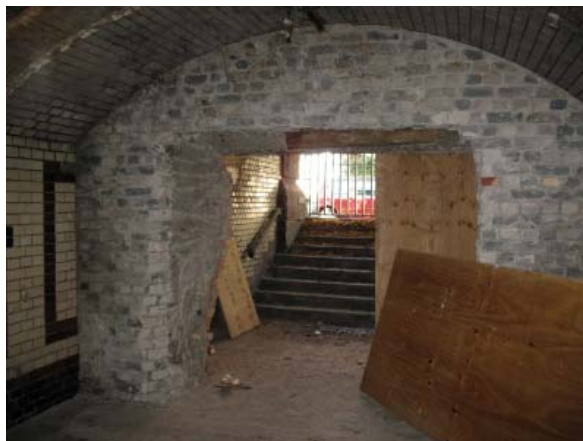
Fig. 9 Mur intérieur condamnant l'accès au tunnel.
