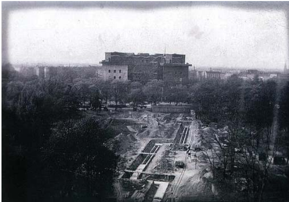
Fig. 65 Construction du tunnel de liaison entre les deux forts.
