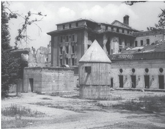
Fig. 49 Cheminée de ventilation du bunker du Führer en juillet 1947.
