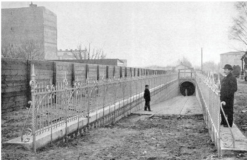
Fig. 15 Rampe d'accès au tunnel du côté Stralau.
