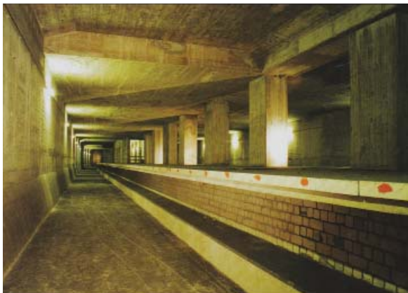
Fig. 36 Tunnel abandonné à la gare Innsbrucker Platz en 1996.
