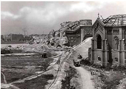
Fig. 71 Rampes avec voies ferrées pour acheminer les gravats.
