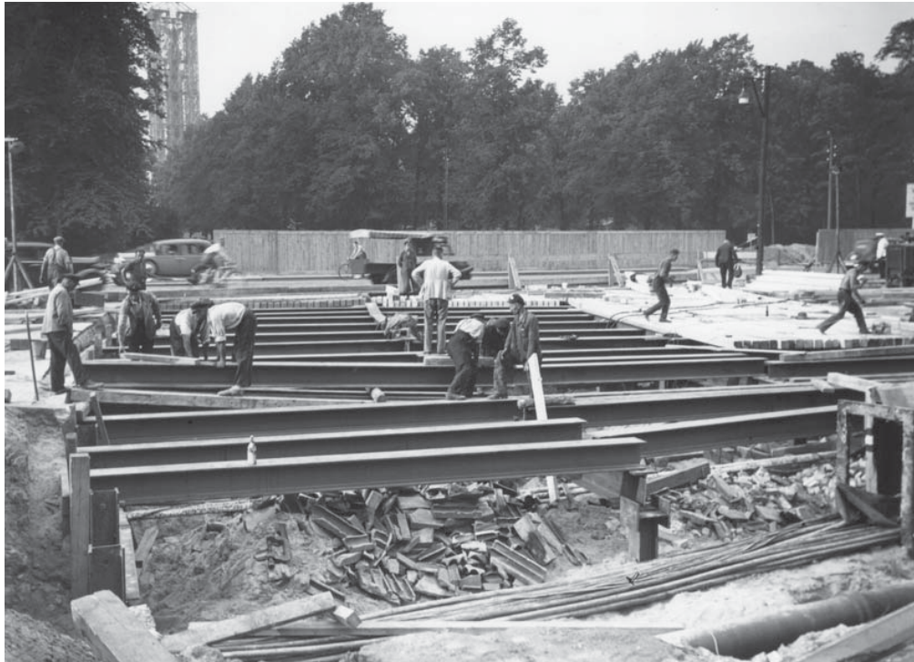
Fig. 62 Construction des tunnels en tranchée couverte.
