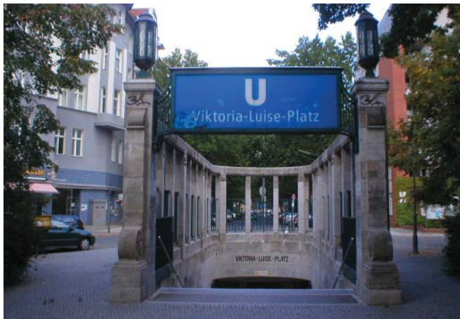
Fig. 31 Accès à la gare actuellement, les colonnes donne l'image d'une pergola.
