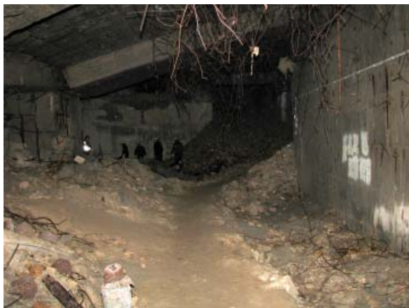
Fig. 75 Intérieur du bunker.
