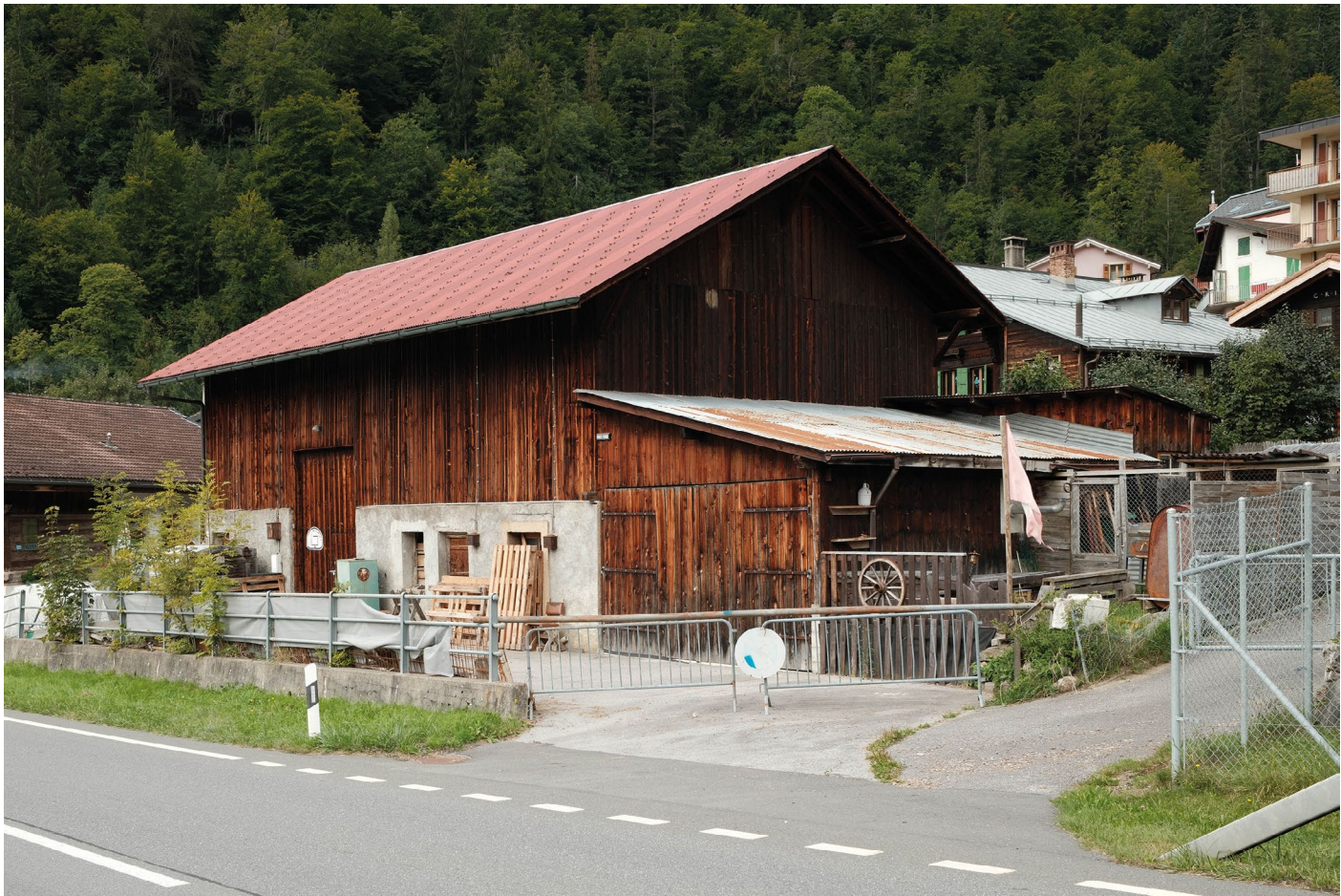
Grange existante de la parcelle
