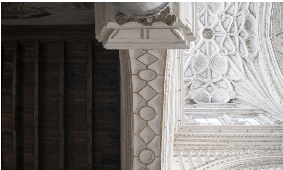
Différence de hauteur, de forme et de matériaux entre les deux architectures
