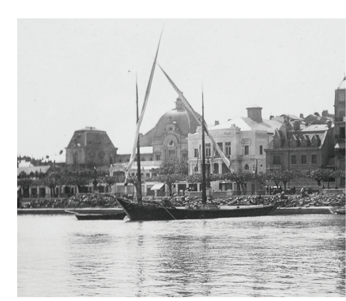
Amarrage au quai marchand des Pâquis
