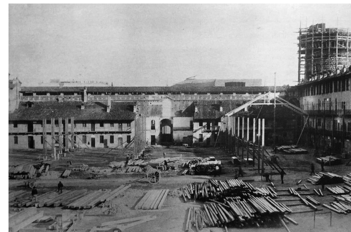
Les travaux de reconstruction des tours latérales sont en cours et les créneaux sont totalement absents. Installation de pavillons dans la piazza d'armi du Castello Sforzesco pour l' Esposizioni Riunite de 1894. Castello Sforzesco, 1894.
