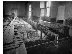
Installation de tuyaux de chauffage au sol. Sala delle Asse, Mario Perotti, 1955. Fondo Allestimenti Museali Milano, AM 418.
