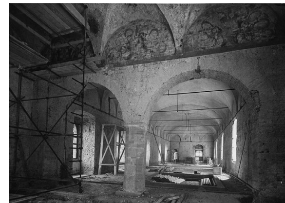
Restauration de BBPR. Ouverture de la paroi entre la salle I et II. Sala I et II, Mario Perotti, 1956. Fondo Allestimenti Museali Milano, AM 55/B
