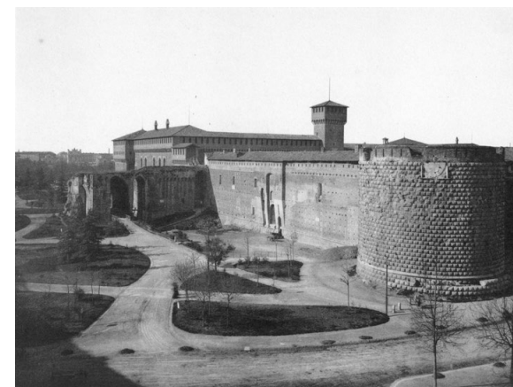
Vue extérieure de la Torrione di Santo Spirito , du jardin extérieur, du Rivellino di Porta Vercellina et du sommet de la Rocchetta et de la Torre di Bona di Savoia . Castello Sforzesco , vue de la façade Sud-Ouest, Achille Ferrario, photographie, 1895. Raccolta Luca Beltrami , RLB 2192/1
