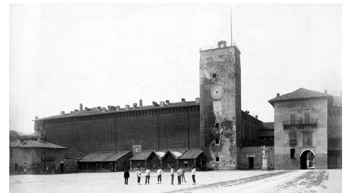
Le château avant sa première restauration. Castello Sforzesco, piazza d'armi , photo, 1880. Raccolta Luca Beltrami , RLB 2689
