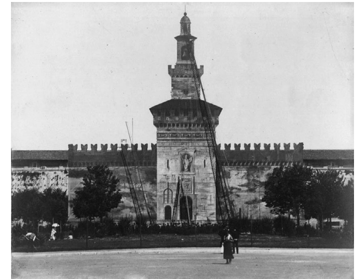
Mock-up de la tour et des remparts pour l'étude du projet à réaliser par Luca Beltrami. Castello Sforzesco , Torre di Filarete , Origoni, photo, 1893, Raccolta Luca Beltrami , RLB 2213/B.
