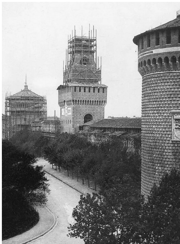
Travaux de restauration terminé sur la Torrione del Carmine (en premier-plan) et en cours sur la Torre di Filarète et la Torrione di Santo Spirito . Castello Sforzesco, Façade Sud-Est , 1904.
