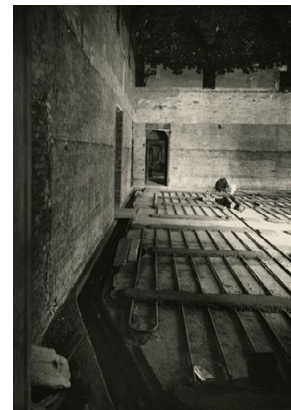
Installation de tuyaux de chauffage au sol. Sala delle Asse, Mario Perotti, 1955. Fondo Allestimenti Museali Milano, AM 418.
