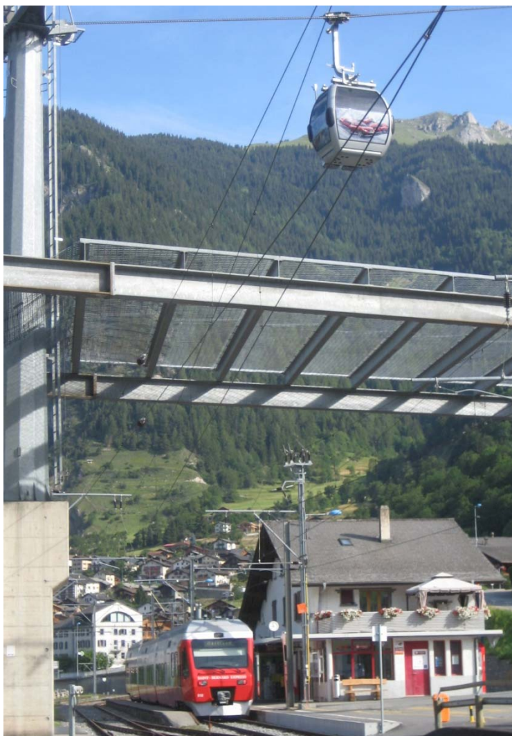
Fig.27 | Interface “quai à quai” à la gare du Châble
