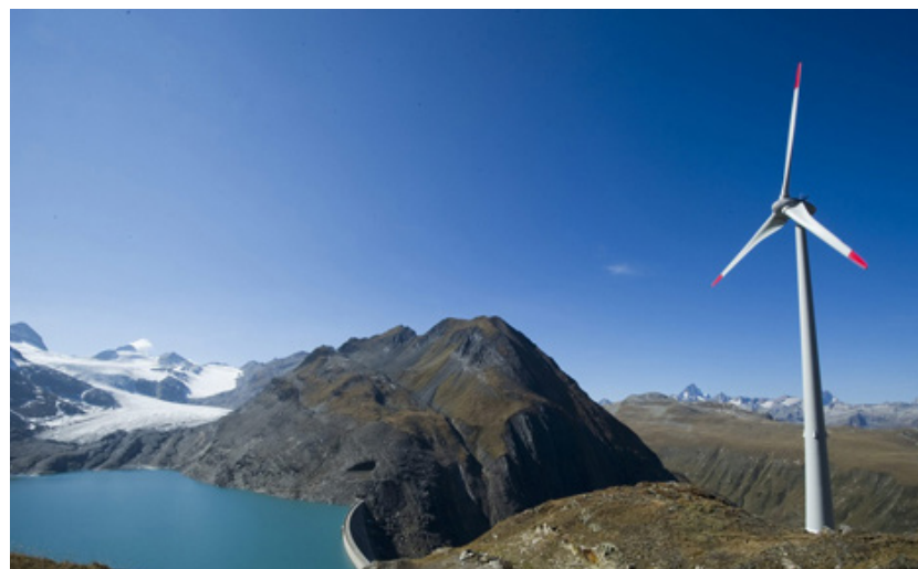
Fig.32 | Nouvelle éolienne au col du Nufenen
