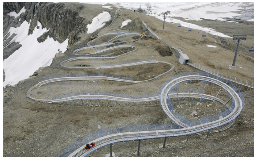
Fig.17 | Circuit de luge sur rail aux Diablerets
