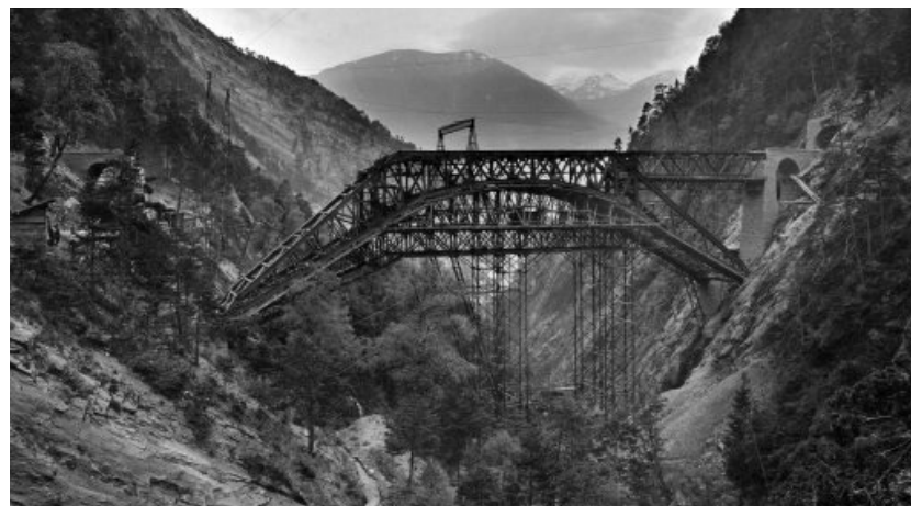
Fig.5 | Construction du viaduc du Bietschtal sur la ligne ferroviaire du Lötschberg, 1912
