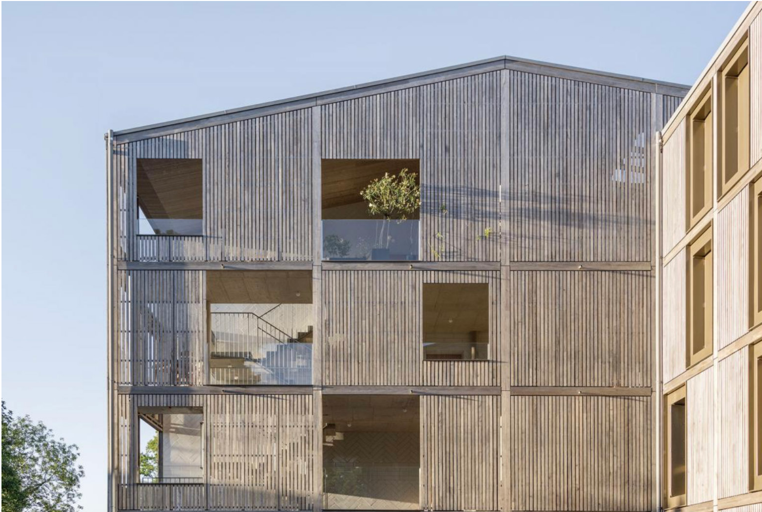
Rigaud 55, Genève, Bonhôte Zapata Architectes
