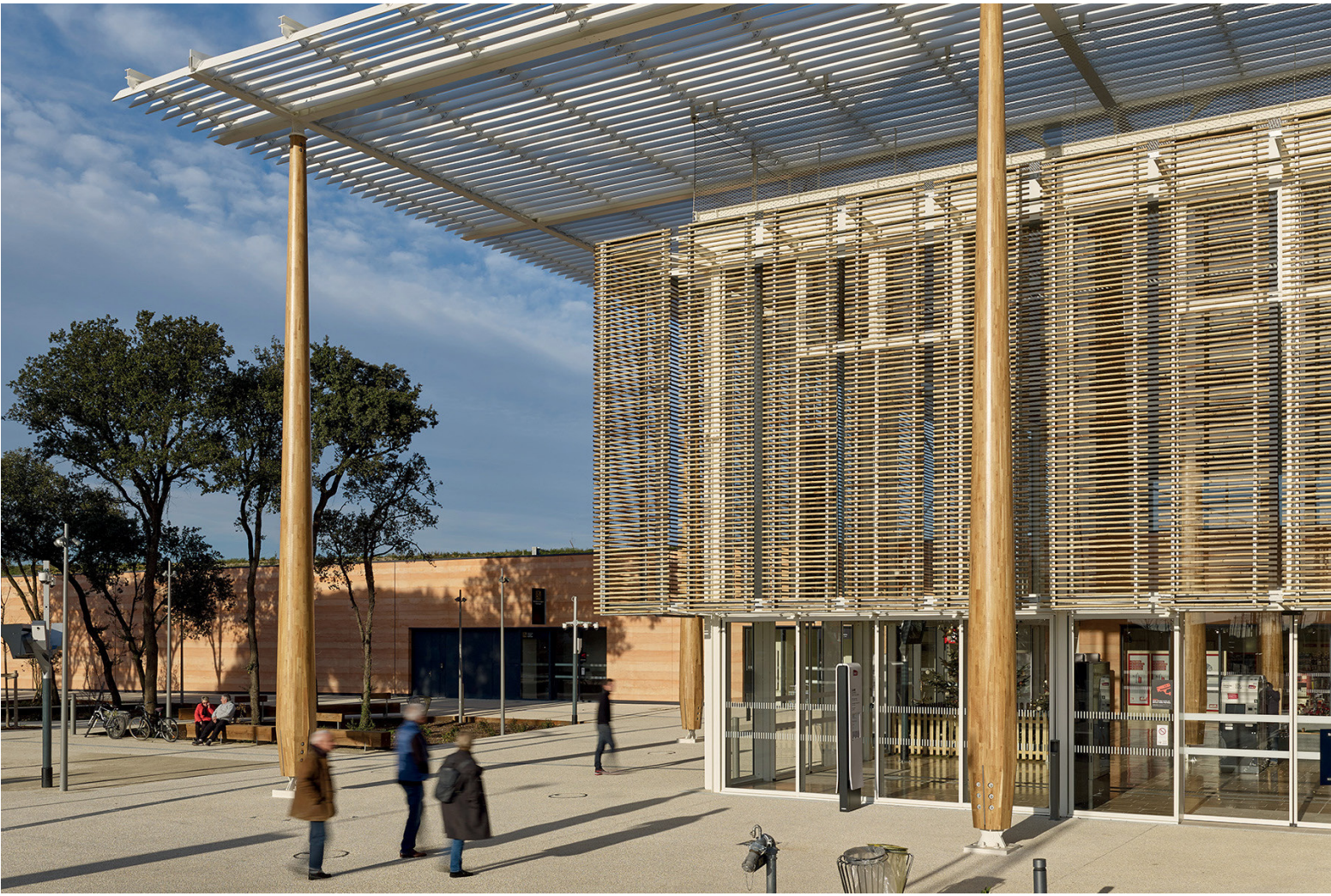
Gare de Nîmes-Pont-Du-Gard, AREP
