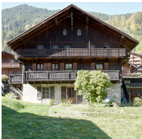
Pignon aval Patrimoine Champéry, 2018
