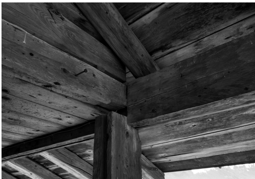
Détail galerie sud Groupe de A. de Pestors, 2018
