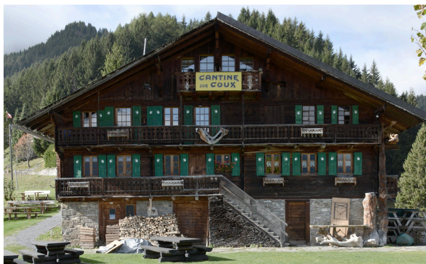
Pignon aval Patrimoine Champéry, 2018
