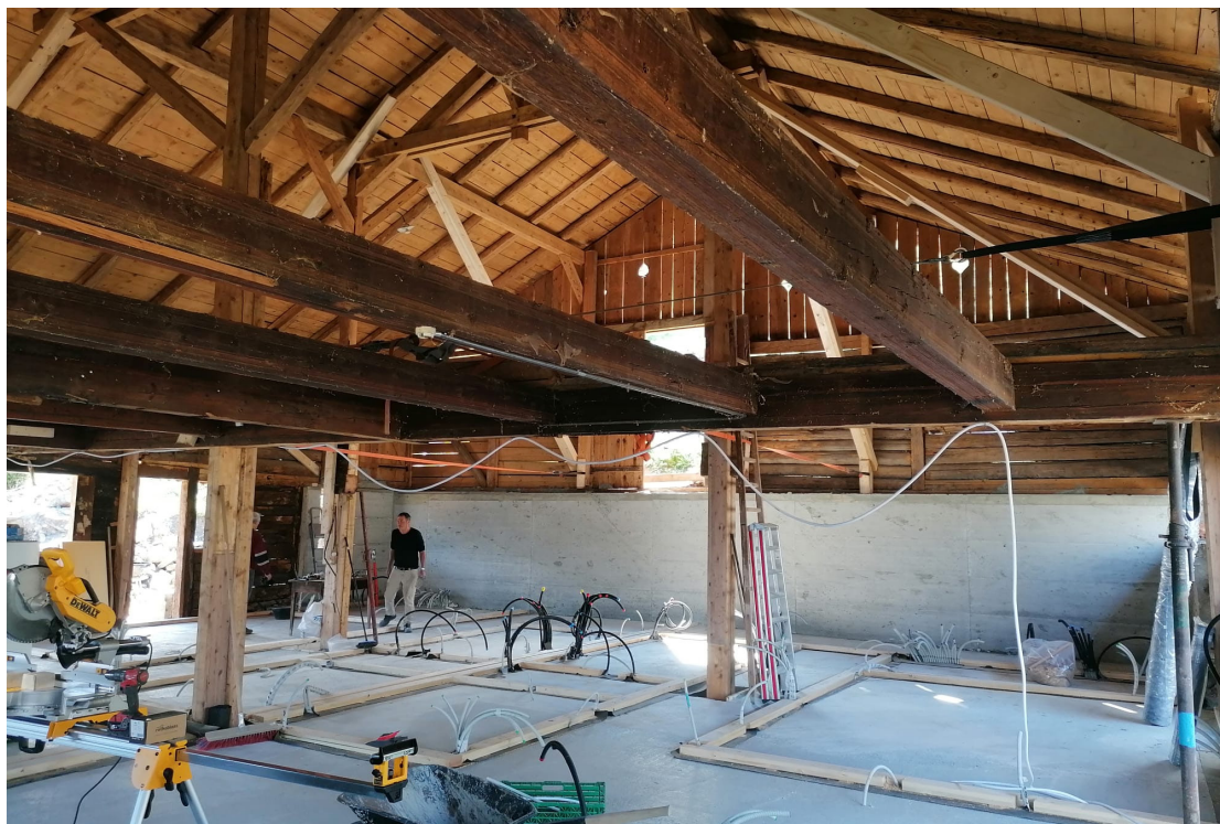
Avant pose des châssis K. Besse, 2020
