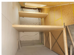
Vue après pose préfabriqué G. Parvex, 2021
