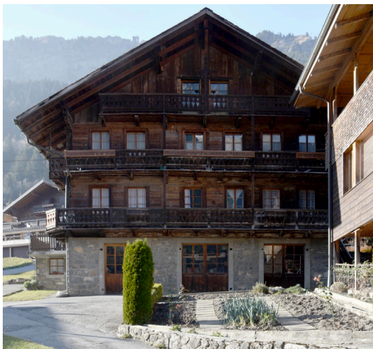
Pignon aval Patrimoine Champéry, 2018
