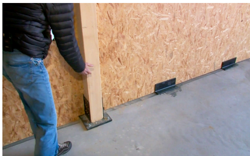
Détail des renforts Canal 9, 2014
