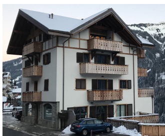
Bâtiment similaire, avant 1920, rénové en 2019
