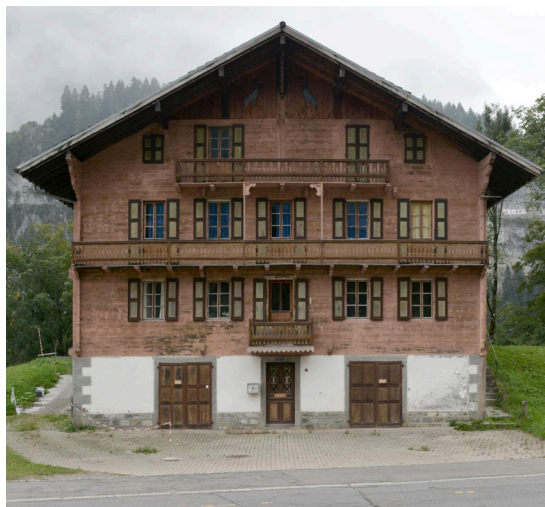
Pignon amont Patrimoine Champéry, 2018
