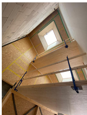
Vue cage d'escalier G. Parvex, 2021
