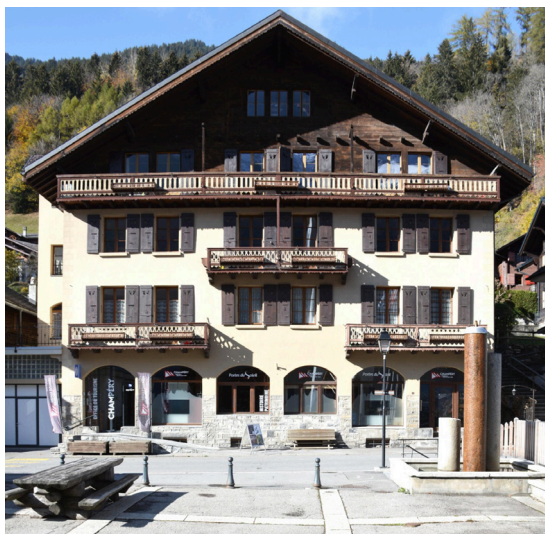
Pignon aval Patrimoine Champéry, 2018
