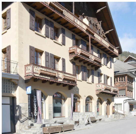
Pignon aval Patrimoine Champéry, 2018
