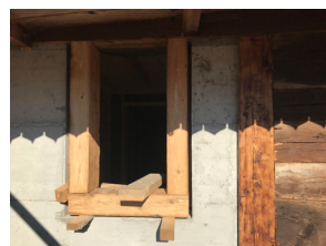
fenêtre ancienne écurie B. Parvex, 2021
