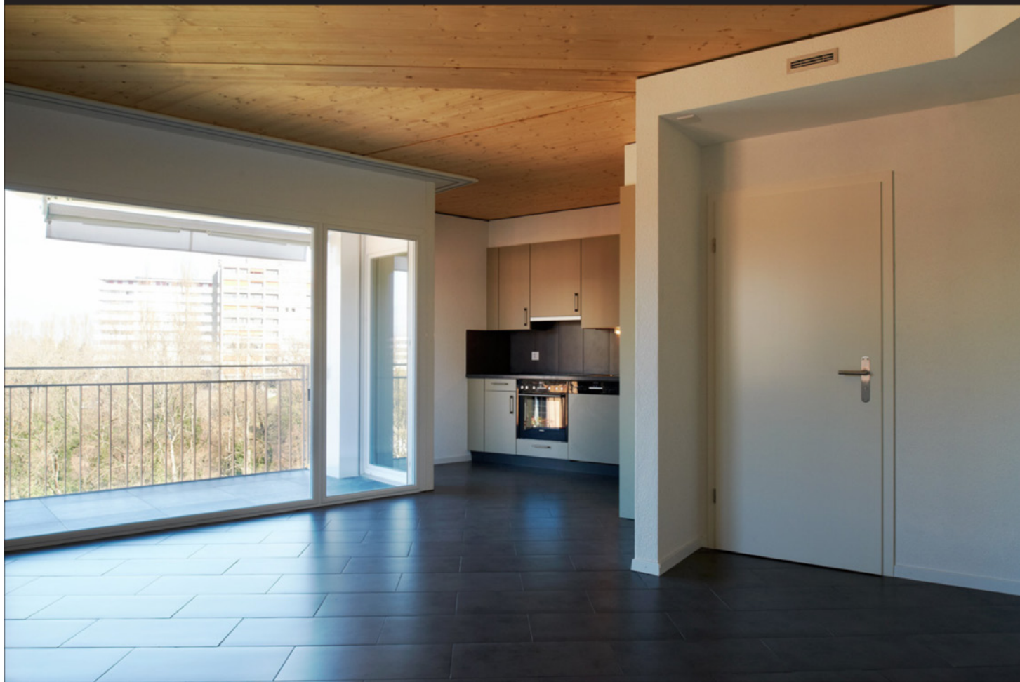
Immeuble «La Paix» à Nyon, de Benoît & Partenaires, 2014
