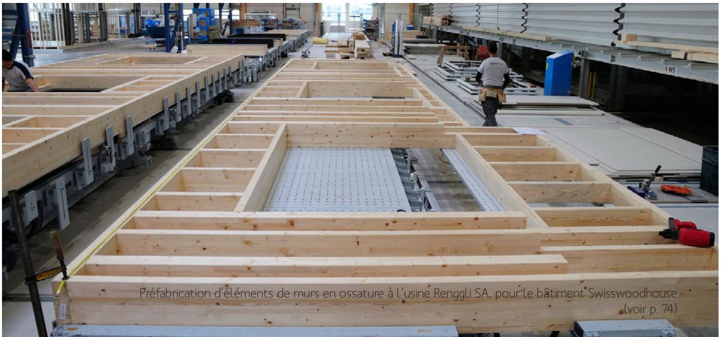
Composition finale d'un mur en ossature
