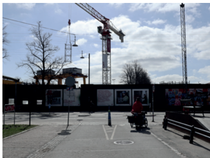
Entrée sur le site par le Nord
