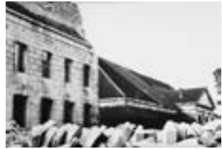
Fig. 56 - photographie de la Maison du Directeur dynamitée
