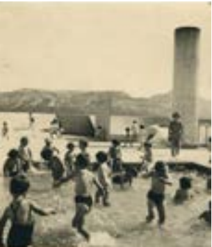
Fig. 52 - photographie des enfants de l'école maternelle jouant sur la toiture
