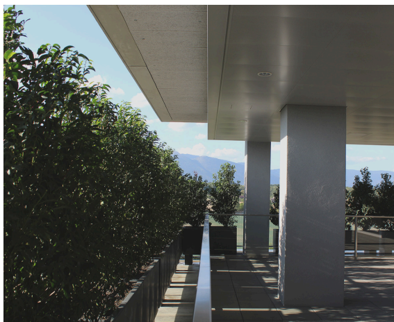
Terrasse végétalisée - Tour C2 - Groupe H, Meyrin
