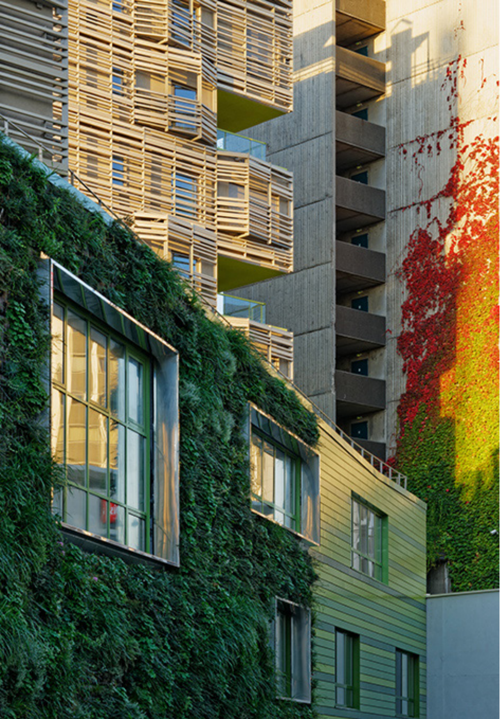
Façade végétalisée - Ecole polyvalente - Atelier d'architecture Phileas, Clichy-Batignolles, Paris
