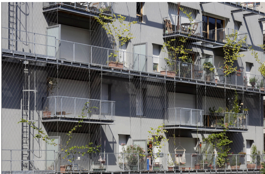
Façade végétalisée - coming-out - Edouard Francois, Grenoble
