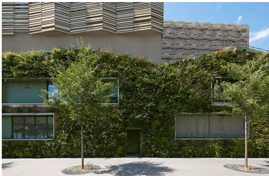
Façade végétalisée - Ecole polyvalente - Atelier d'architecture Phileas (2) Clichy-Batignolles, Paris
