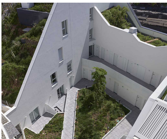
Infiltration de la végétation dans le bâtiment - Agence Saison Mennu (2) Clichy-Batignolles, Paris
