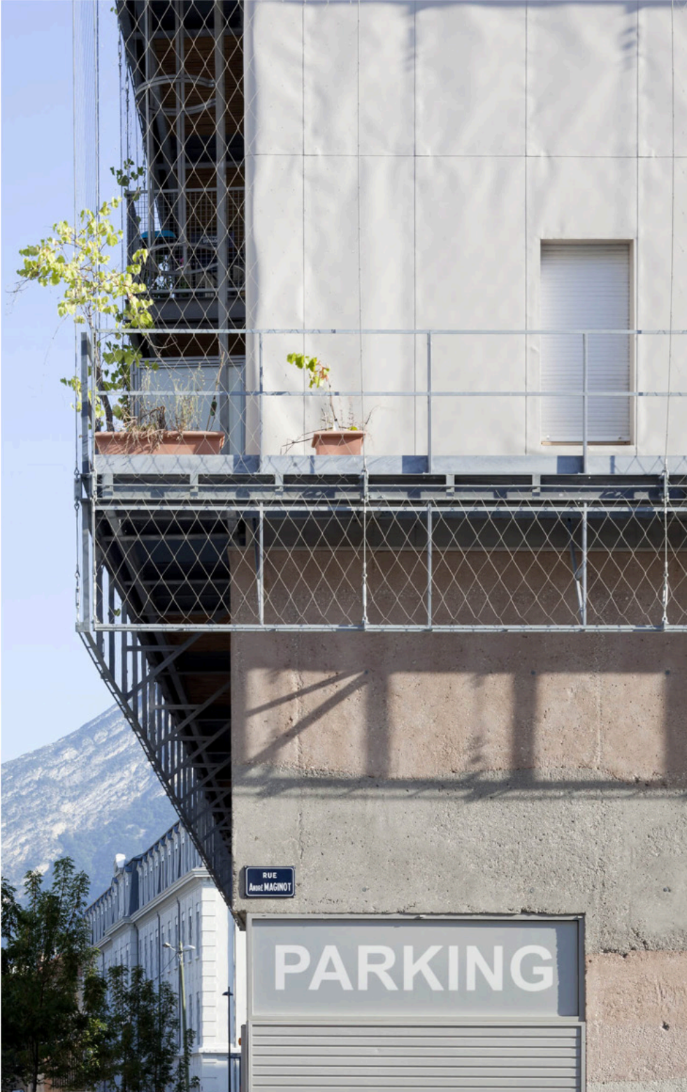
Façade végétalisée - coming-out - Edouard Francois, Grenoble
