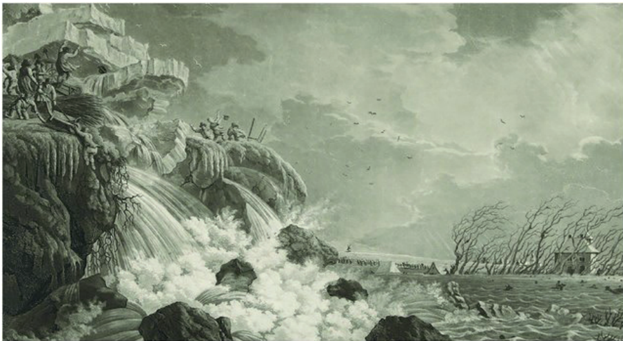
Dessin historique de la brèche d'une digue près de la ville de Bemme au Pays-Bas - fig. 1
