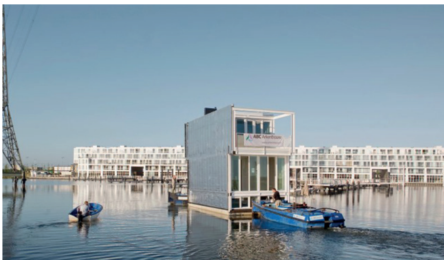
Transport et installation d'une maison, Quartier Ijburg - fig. 14
