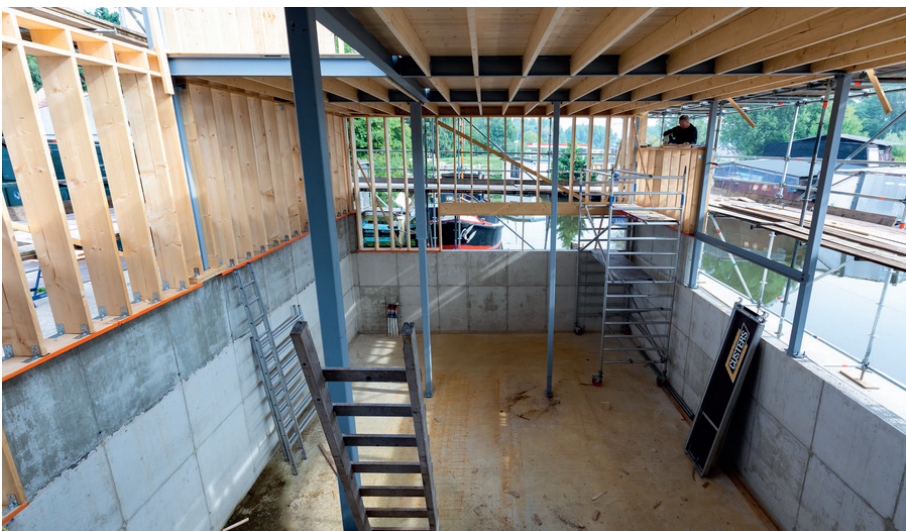
Structure d'une maison flottante, Quartier Schoonschip - fig. 13
