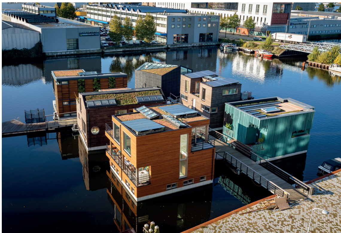
Vue d'un ponton et sa liaison à la terre - fig. 28
