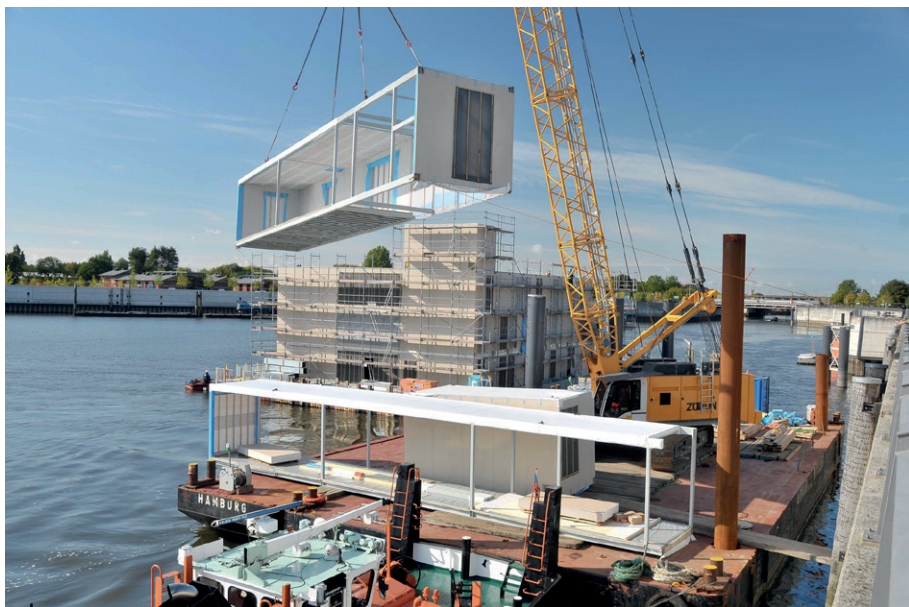
Assemblage des éléments préfabriqués - fig. 10
