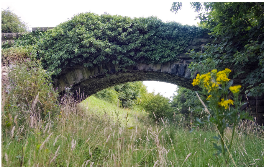
[10] Végétalisation d'un pont facilitant le passage d'une berge à l'autre de certains micromammifères et d'invertébrés (TJBlackwell, 2009)
