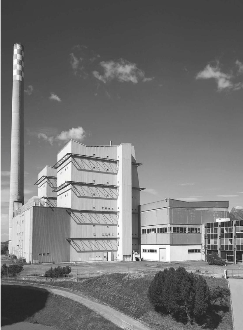
Chaudières et salle des machines, bâtiment d'exploitation (photo © Needler)
