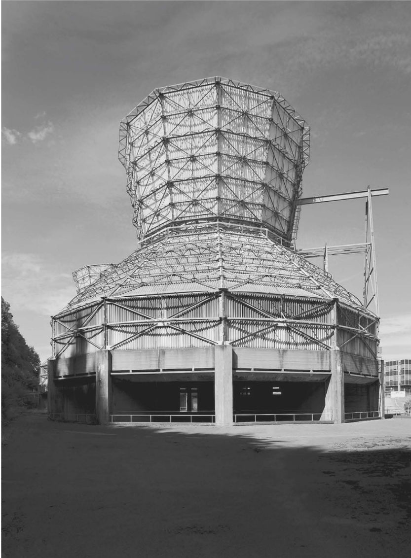
Tour de refroidissement (photo © Needler)
