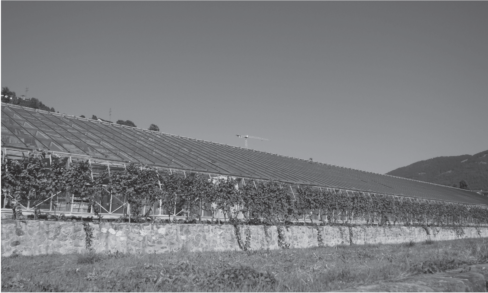
Vue intérieure sur les serres à l'abandon.
