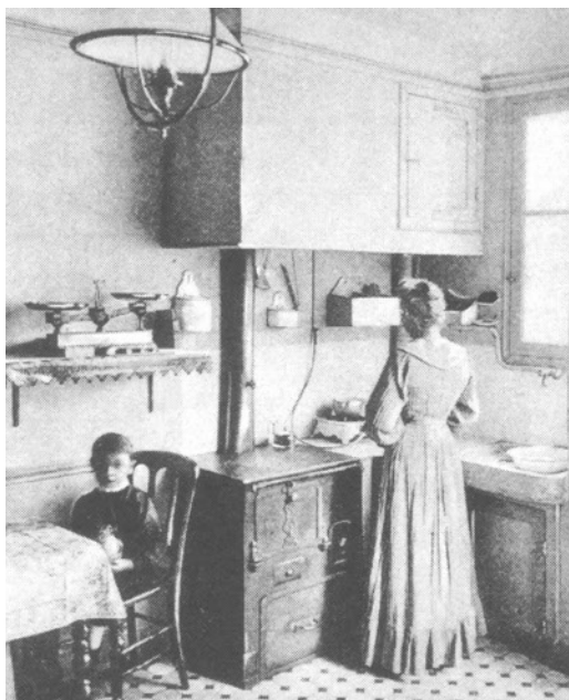
13. Vue d'une salle commune , rue de l'Amiral-Roussin, 1907.
