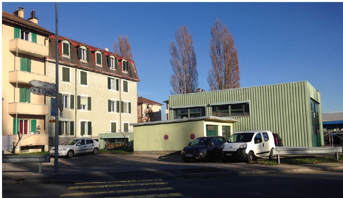
Logement et industrie
