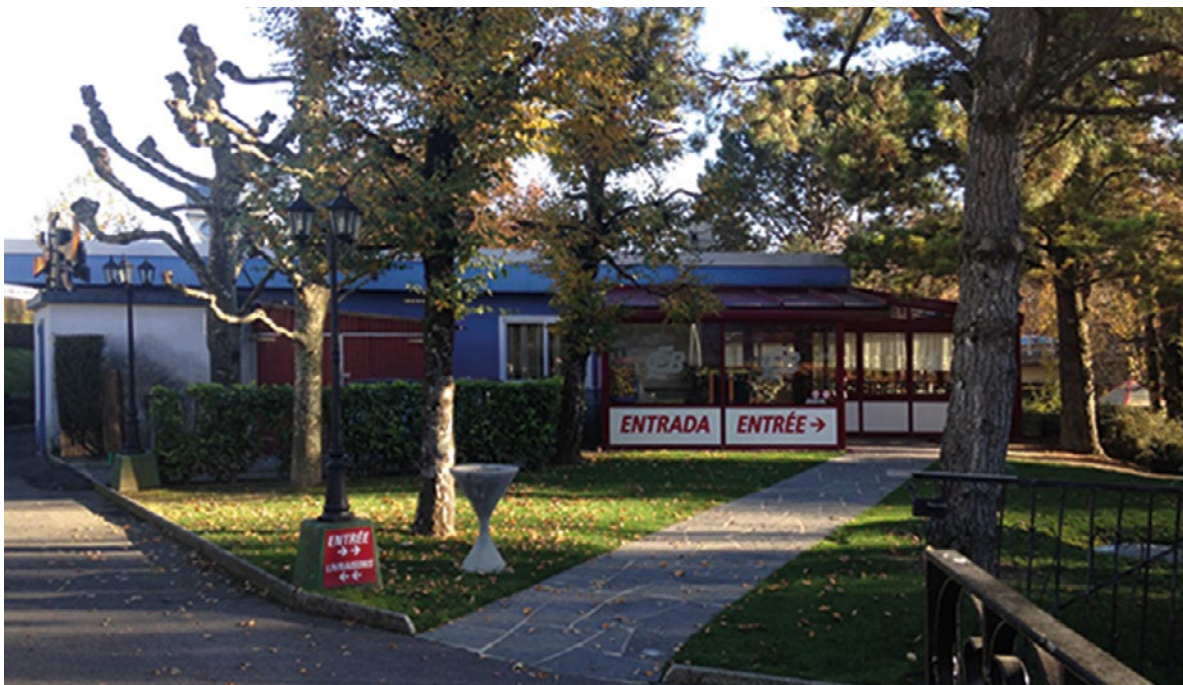
Bâtiment public : centre espagnol
