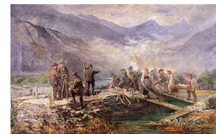
Fig. 68 Travaux de correction du Rhône à Rarogne , peinture à l'huile, Raphaël Ritz, 1 janvier 1888
