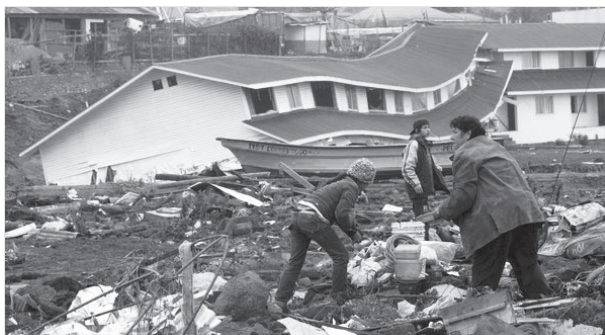
[1.2] 2010 - Effets sur les bâtiments, Pelluhue, Chile
