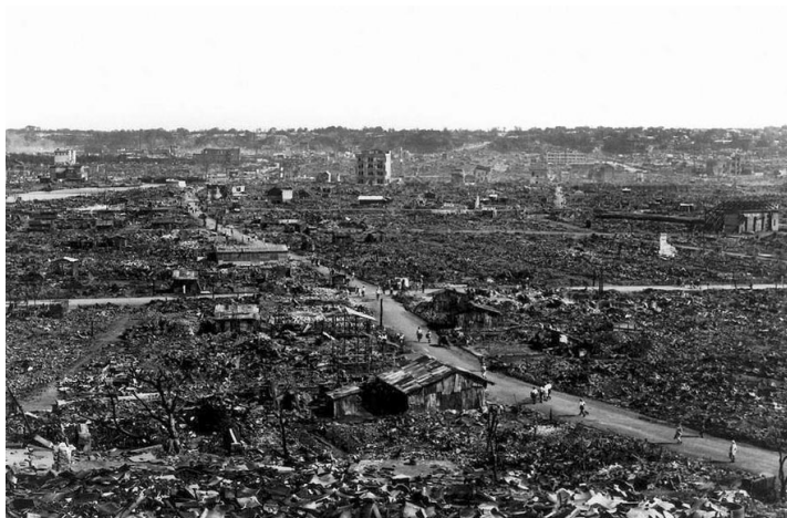
[1.18] 1923 - Séisme Grand Kanto, Japon
