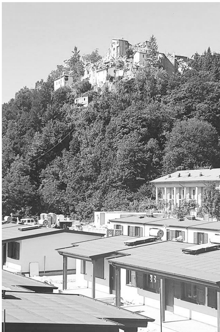
[1.11] Double structure urbaine après la construction d'urgence - Arquata del Tronto, Italia
