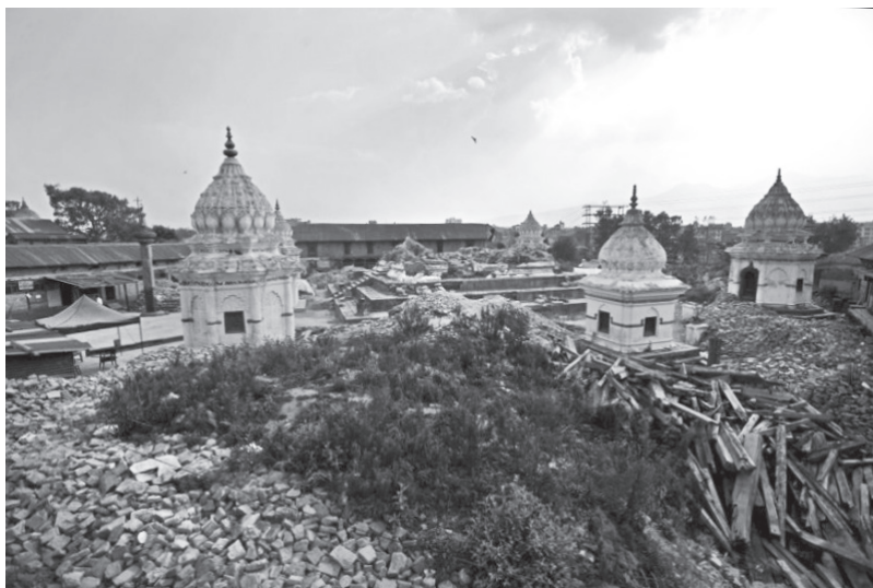
[1.27] 2015 - Kathmandu, Nepal - Effondrement d'un ensemble ouvert
