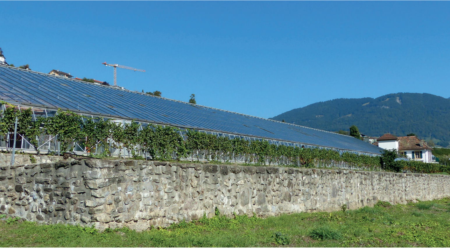
Vue des murs du Lavaux et des serres dans les vignes.
