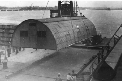
Réemploi d'une Hut Quonset dans une deuxième base militaire au Japon, 1947 © US Army Corps of Engineers
