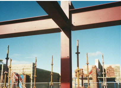
Structure métallique en acier de réemploi, BedZED © BioRegional
