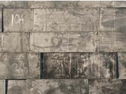
Détail de façade en tableaux noirs réemployés, Pavillon Galileo © Studio 804
