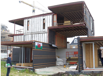
Fin de la pose de l’isolation, Villa Welpeloo © Superuse Studios
