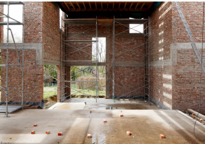
Construction de structure en brique de réemploi, dnA House © Stijn Bollaert
