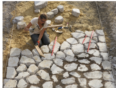
Mise en œuvre de l' Opus Incertum © Bellastock
