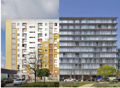
Transformation de logement du quartier Grand Parc © Philippe Ruault
