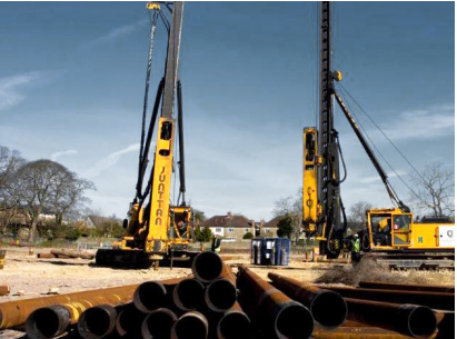
Préparation de la mise en œuvre des fondations en pieux battus réemployés à partir de tuyaux de l’industrie gazière et pétrolière, projet Town Center Redevelopment Witney à Oxfordshire. © GreenPiling
