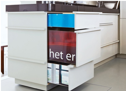
Elements de cuisine en panneaux plastifiés réemployés, Villa Welpeloo © Superuse Studios
