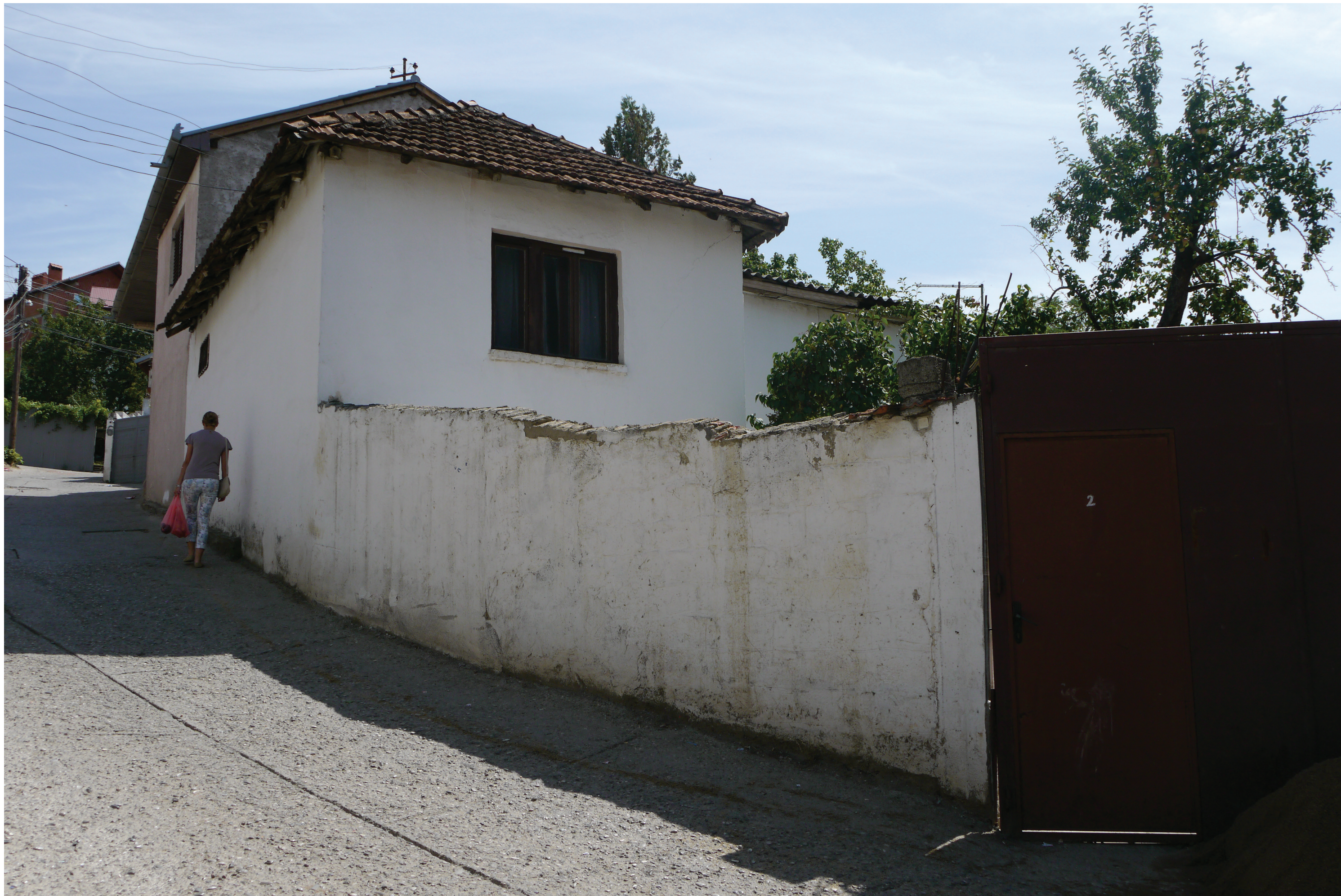
maison traditionnelle dont la privacité est assurée par le peu d'ouvertures sur rue et par le muret protégeant le jardin
