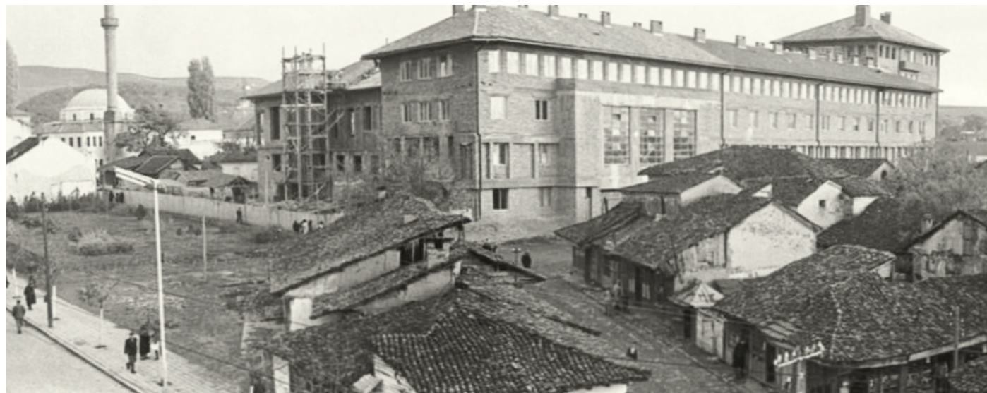
site laissé vide par la destruction du bazar en prévision d'un nouveau centre urbain
