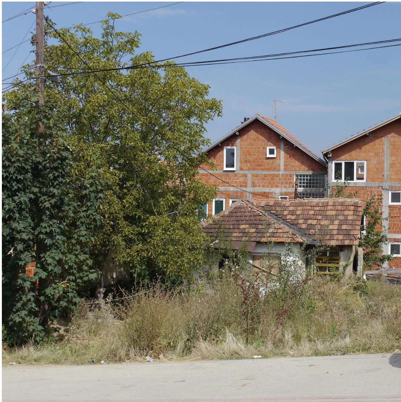
maisons individuelles aux ambitions inassouvies à l'arrière d'une maison vernaculaire en ruine
