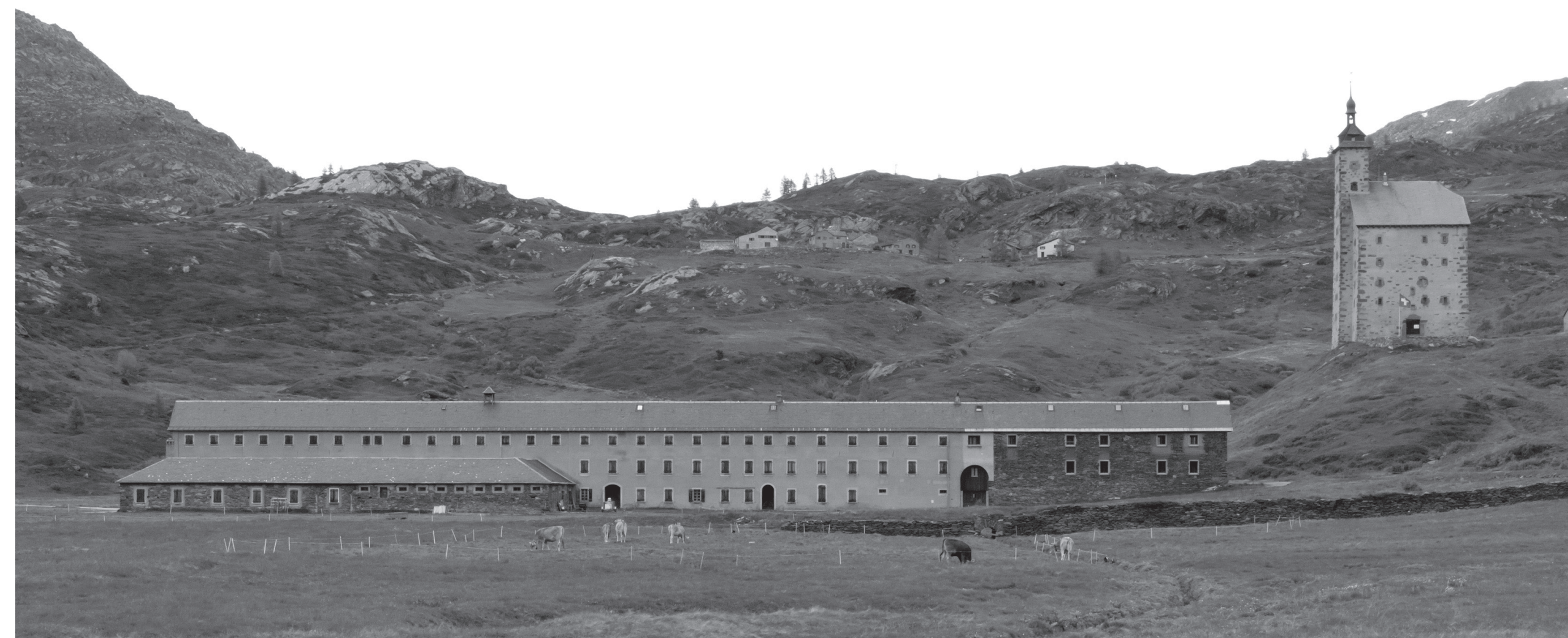
Vue sud de la Barralhaus
